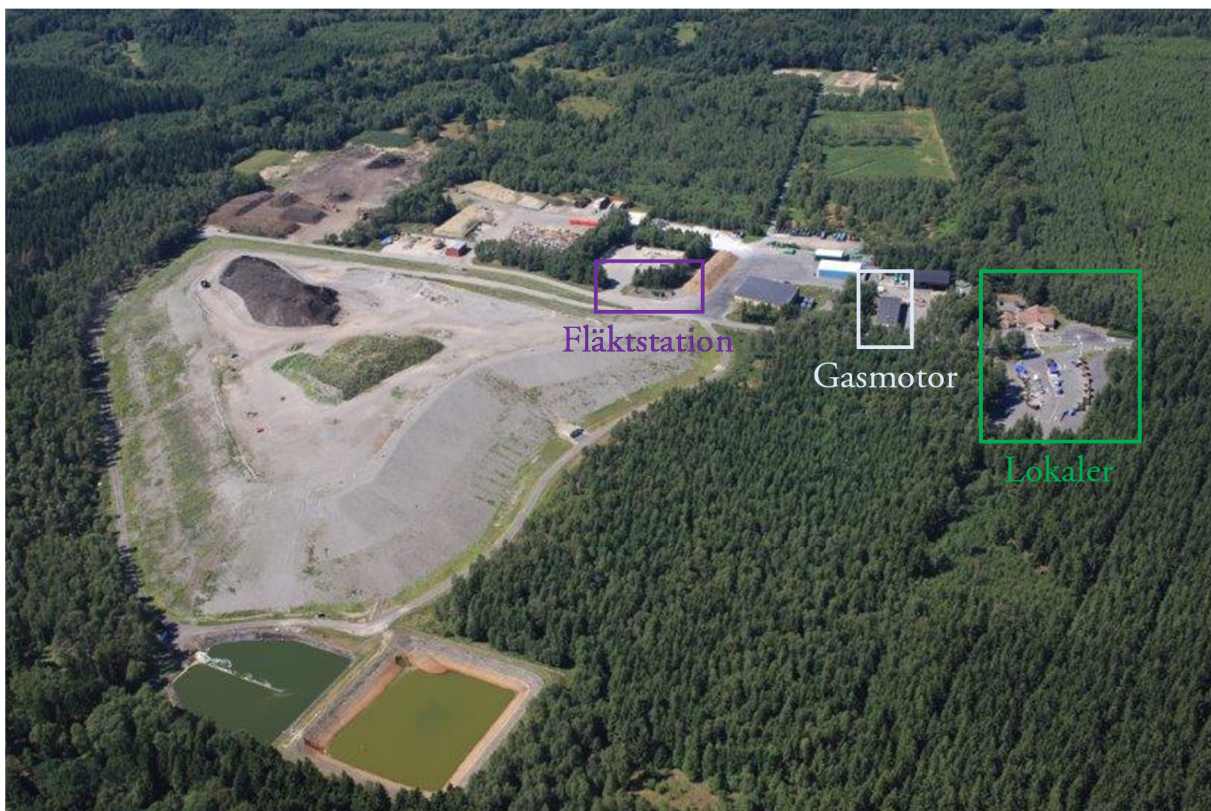
Figur 3.1 Flygfoto över Måsalycke Återvinningscentral. Foto med tillåtelse från Rickard Sjöholm.
