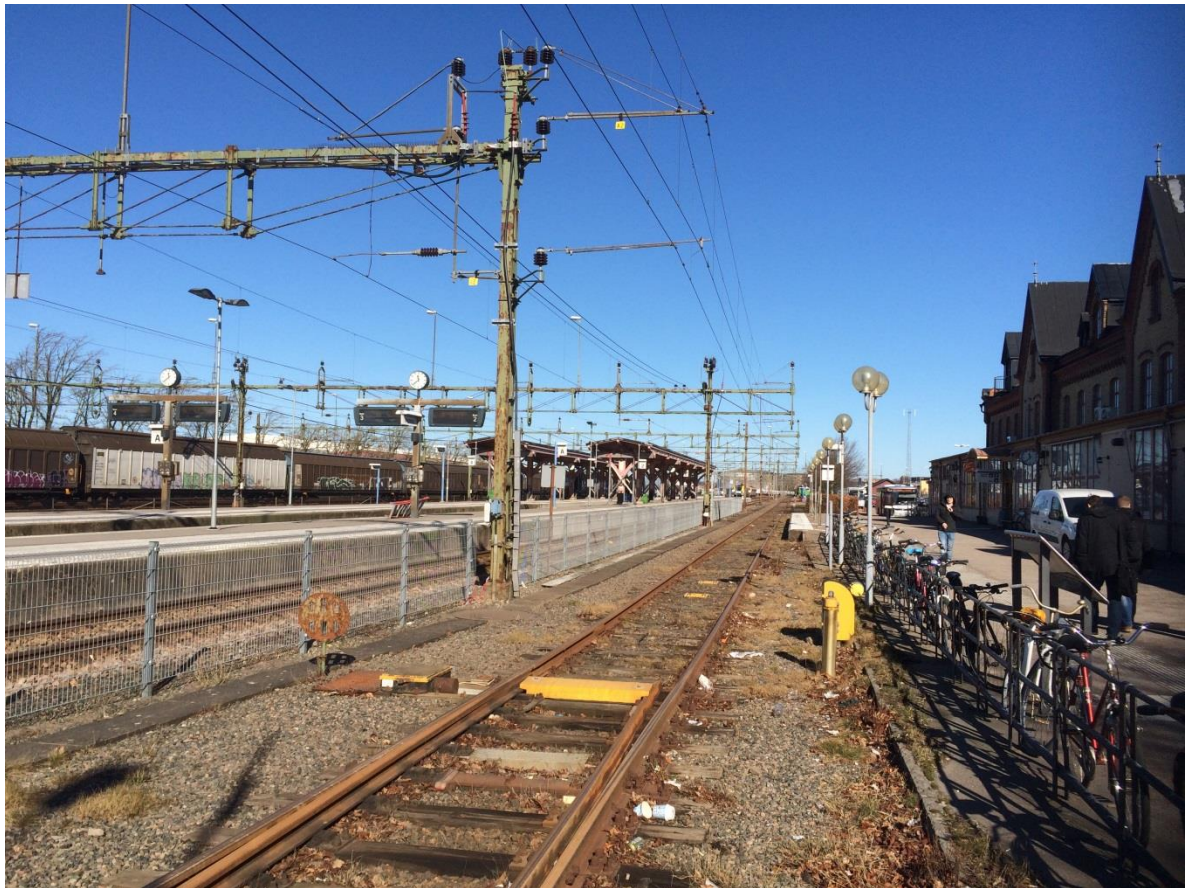
Figur 6: Bild över befintlig station i Varberg
