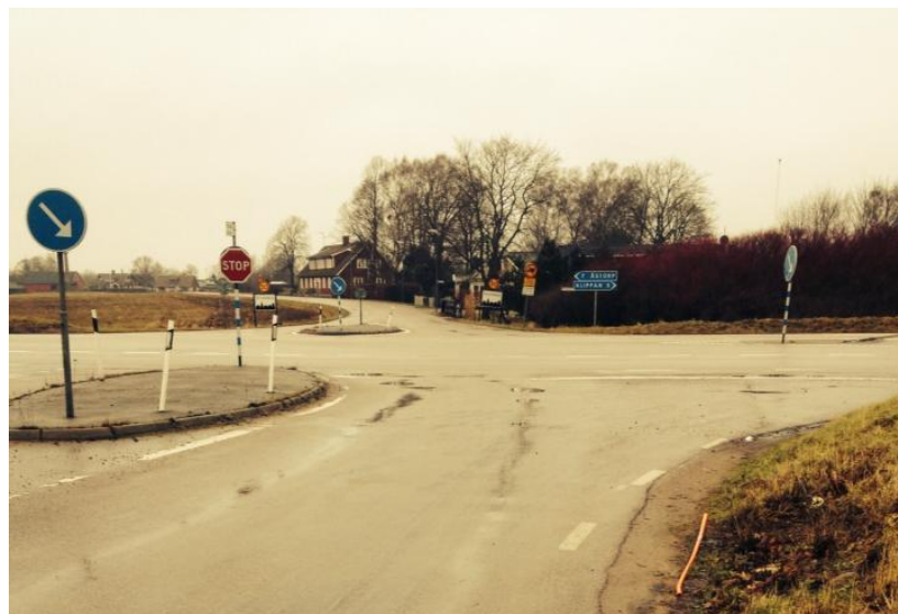
Figur 34 Spårbildning sekundärväg, Maglabyvägen. (Foto: Jennifer Nilsson)
