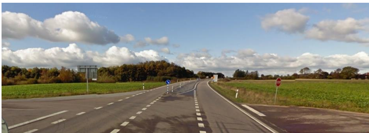
Figur 25 Riksväg 21/Hörsdalsvägen, mittremsa som accelerationsfält (Foto: Google Maps, 2010b)
