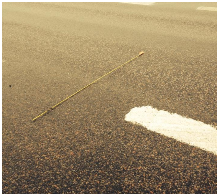
Figur 35 Spårbildning i korsning riksväg 21/Hörsdalsvägen på primärväg. (Foto: Jennifer Nilsson)
