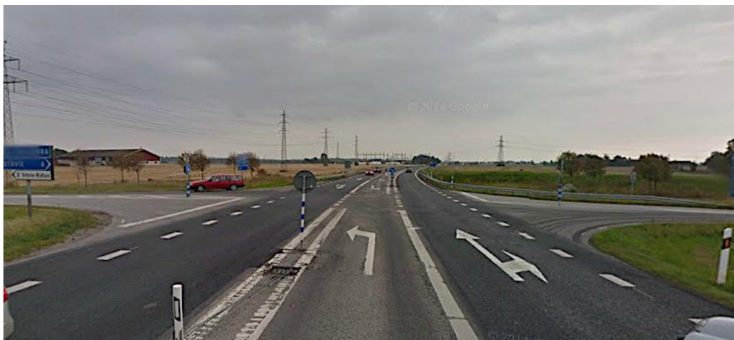
Figur 15 Korsning väg 108/Axel Snickares väg (Foto: Google Maps, 2011a)
