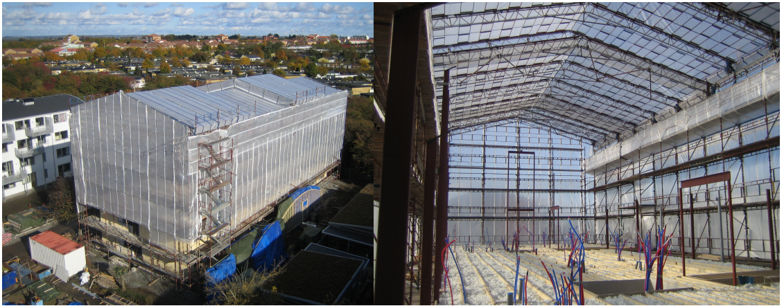
Figur 23. Ett av fallprojektens mobila takväderskydd som var byggt i olika nivåer (Servin 2014).
