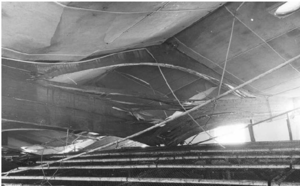
Figur 2.10 – Brott av bumerangbalk (Aicher, S.)
