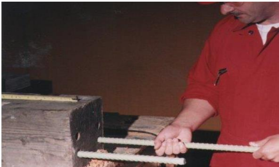
Figur 2.12 – Reparation av befintliga element (Johansson, 2012)
