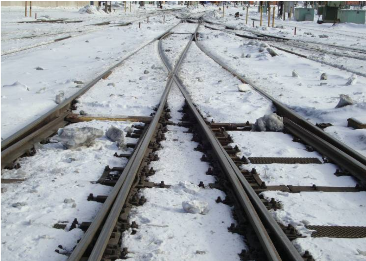
Figur 19 Här kan man se isklumpar som fallit av tåg som passerat (Kloow 2011).
