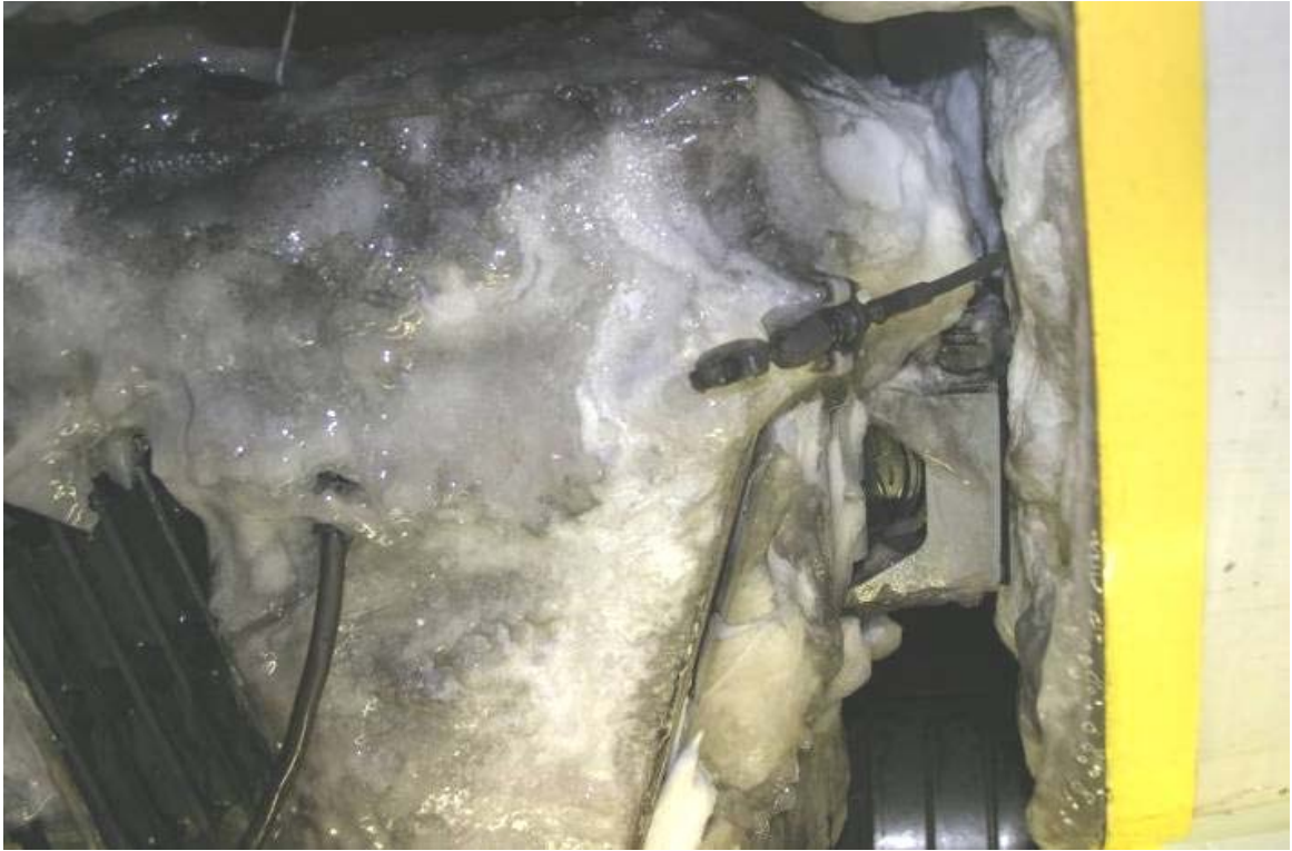
Figur 15 Snöpackning vid kablar (Kloow 2011).
