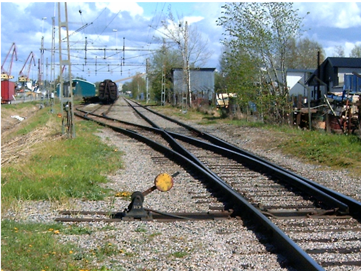
Figur 18 Motväxel, bilden visar tungorna och utformingen av en spårväxel (Strandberg 2005).
