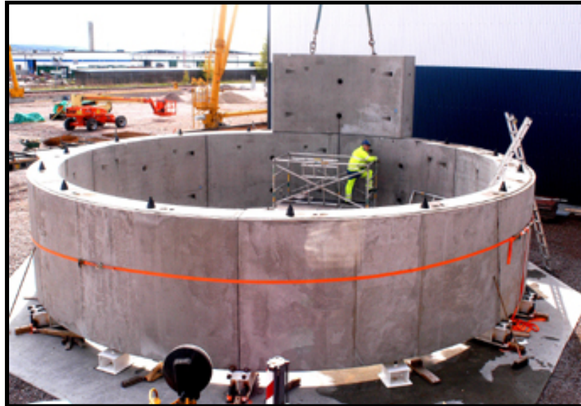
Figur 11 – Tunnelring med 8 segment
