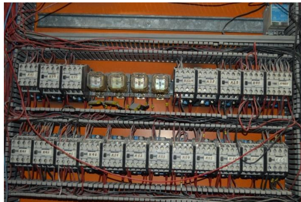
Figur 3: Kontaktorer i styrskåp
