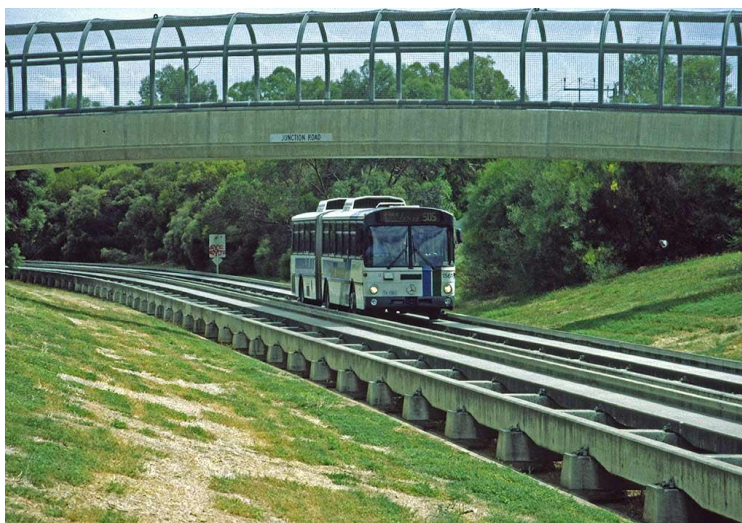
Figur 3-13 Banan i Adelaide är upphöjd på pelare och har en mycket robust konstruktion. Bild: Storbeck (1997), „O bahn adelaide sst“. Licentierad under GPL via Wikimedia Commons
