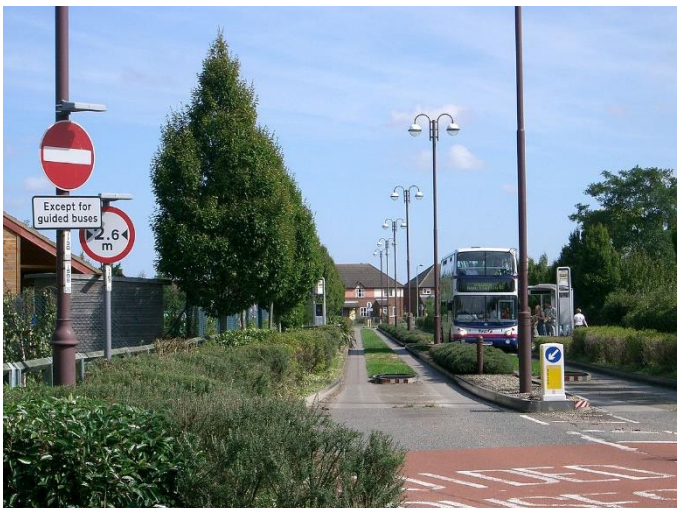
Figur 3-10 Infart till kantstyrd bussbana i Ipswich. Notera den trattformiga utformningen. Bild: Spasmiller (2014b) "Ipswich-UK-guided-busway1". Licens under Public Domain via Wikimedia Commons
