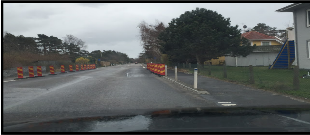
Bild 2 Bilden visar avsmalning av vägen vid Östersjövägen 47 .
