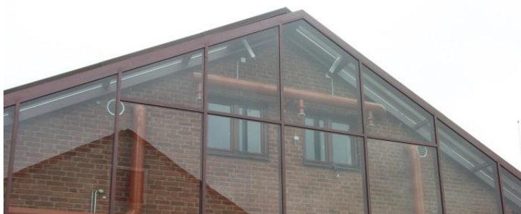
Figur 6 - Vädringsfönster högst upp i glasfasaden, söderfasad.
