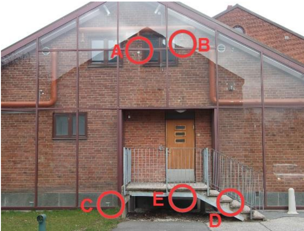
Figur 41- Söderfasaden med markeringar för de egna loggrarnas placering; A: S31a, B: S31b, C: Nr1, D: Nr3, E: S34.
