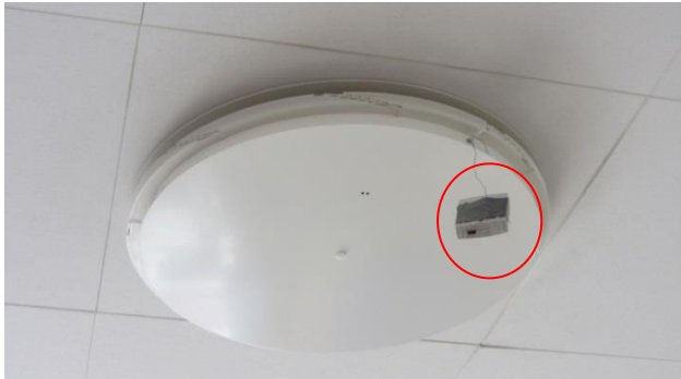
Figur 18. Placering av logger under tilluftsdon.
