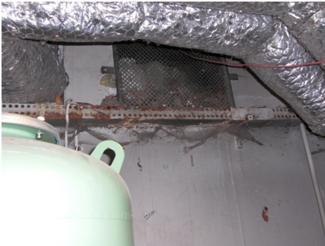
Figur 17 visar ett luftintag med otillräckligt galler och filter.
