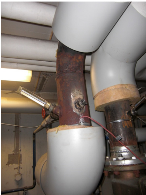
Figur 16 visar korrosion på rör.
