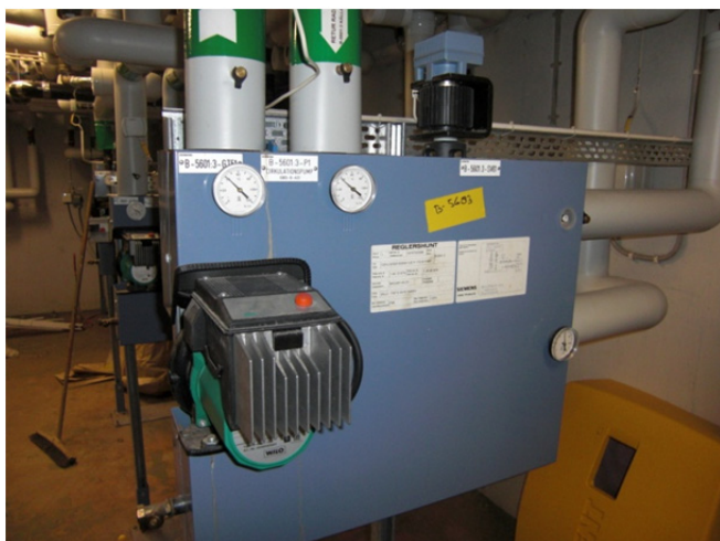
Figur 21 visar en shuntgrupp.
