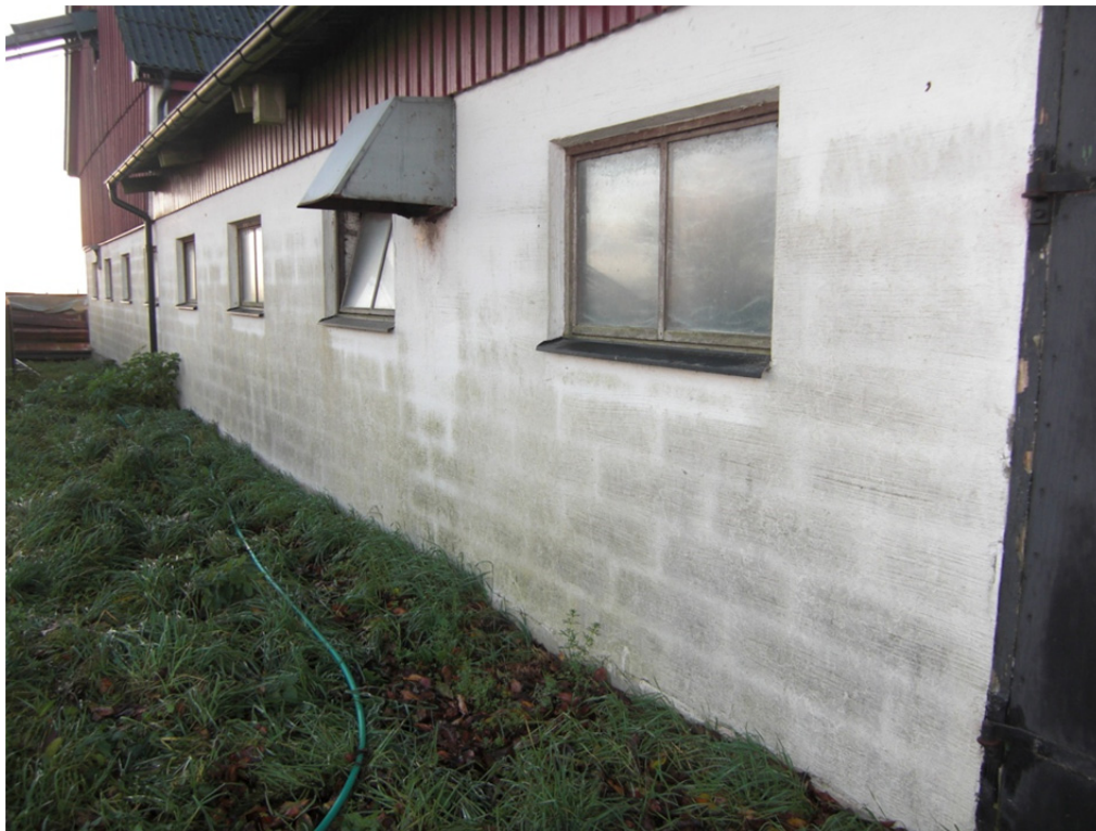
Figur 8 visar köldbryggor, genom den varierande mängd biologisk påväxt på väggen.
