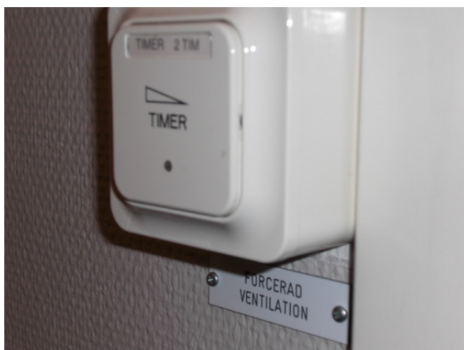
Figur 27 visar en knapp för forcerat flöde.
