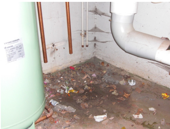
Figur 18 visar resultatet av gallrets icke kompletta funktion i figur 17.
