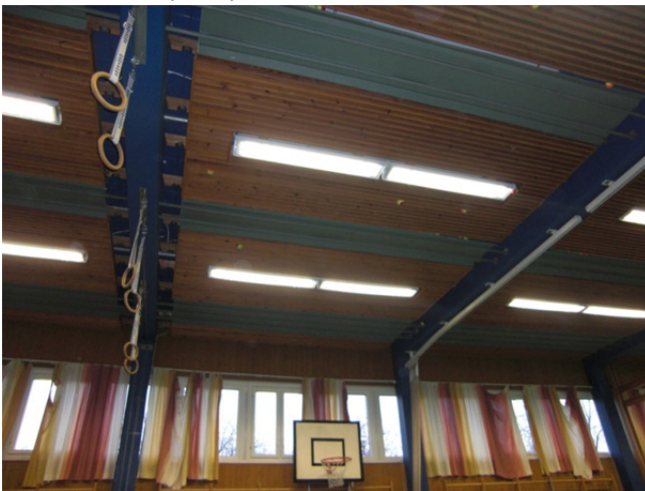
Figur 24 visar värmesystemet i gymnastiksalen, placerade i taket.
