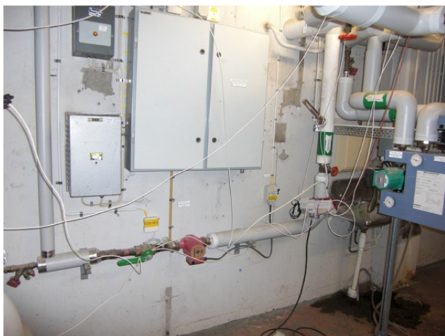
Figur 19 visar pumpen som cirkulerar tappvarmvatten i byggnaden
