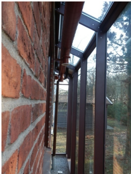
Bild 2.3.1:3 Bild tagen i glasfasaden på västra sidan
