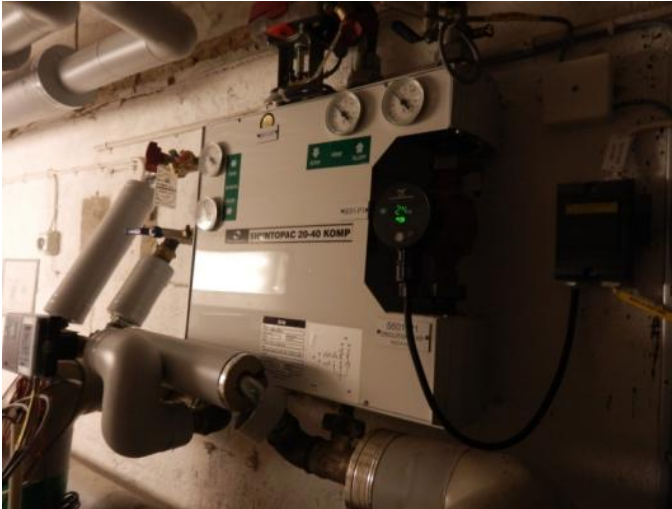
Bild 2.3.2:2 Foto på shuntgrupp i kulvert
