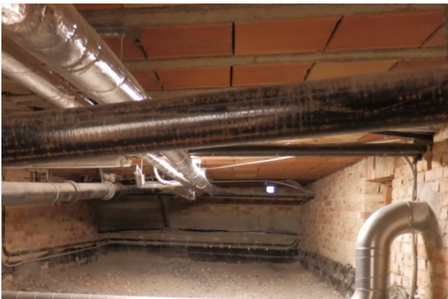
Bild 5.1:3 Foto från krypgrunden.
