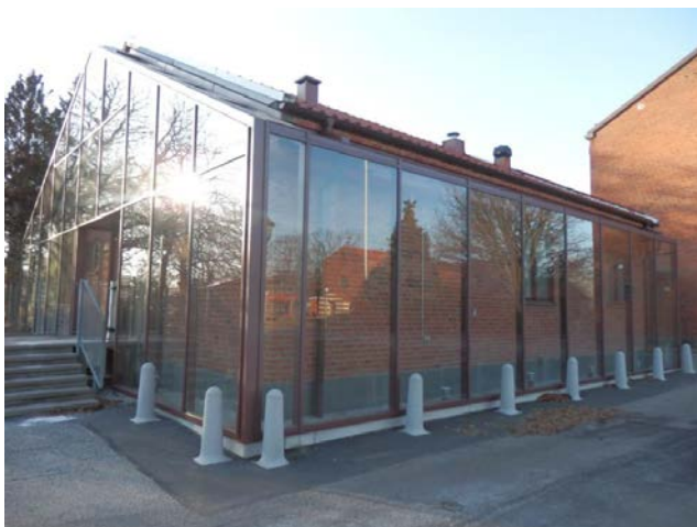
Bild 2.3.1:1 Foto över södra och östra fasaden
