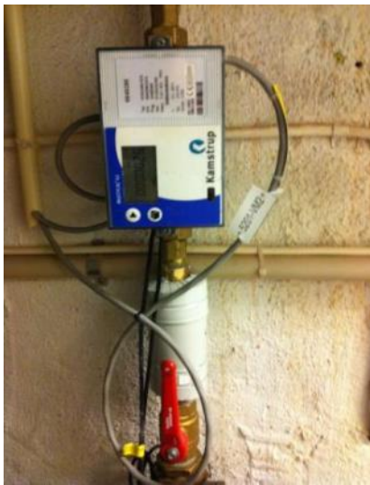
Bild 2.3.3:2 Vänster bild visar tappkallvattenmätare VM2, Höger bild visar kallvattentemperatur.
