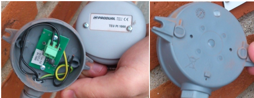
Bild 7:11 Närbild på utetemperaturgivare på fasad.
