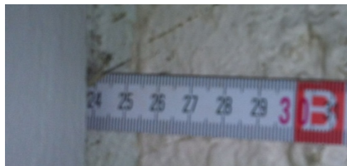
Bild 5.1:4 Mätning av isoleringstjocklek mellan råspont och gipsskiva.
