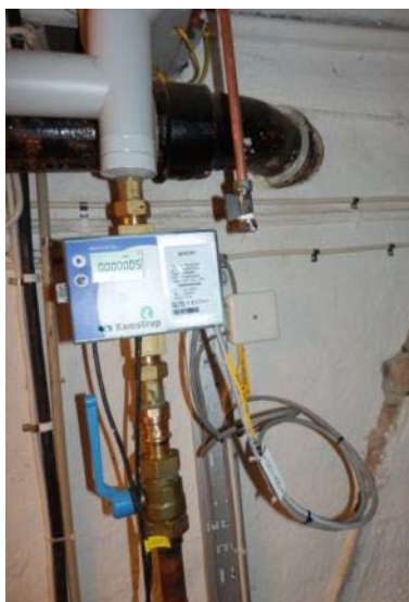
Bild 2.3.3:3 Vänster bild visar tappvarmvattenmätare VM3, Höger bild visar varmvattentemperatur.
