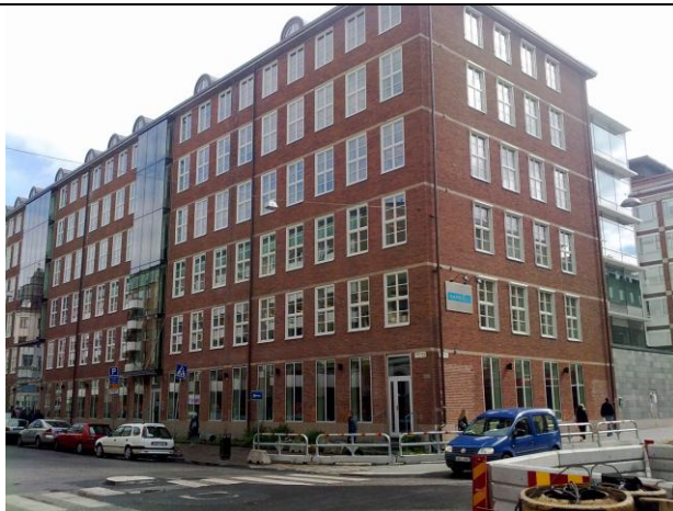
Figur 1. Kv. Skjutsgossen 8 norra och västra fasaden år 2010.
