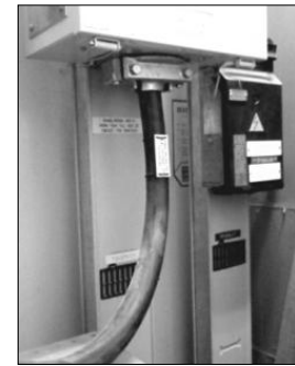
Figur 22 Två Canalis kanalskenor
