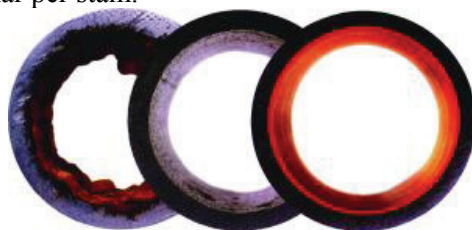
Figur 7 Relining av tappvattenstammar
