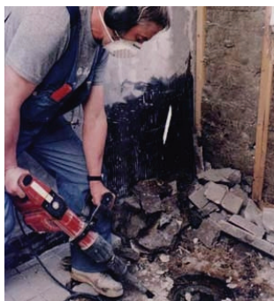
Figur 3 Bila i betong
