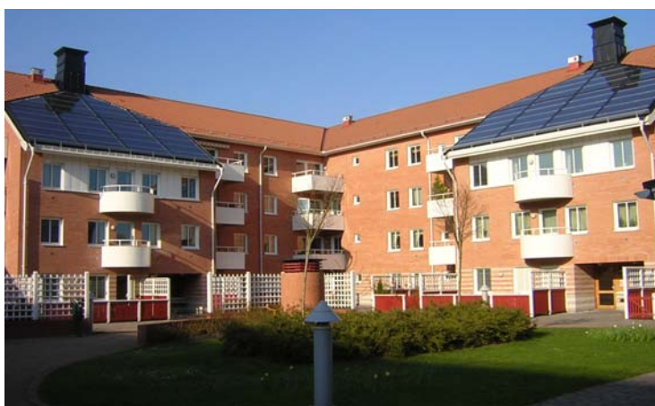
Figur 7.1 De båda solfångarpanelerna på flerbostadshuset i kvarteret Jöns Ols. Den vänstra på bilden är riktad mot söder och den högra mot väster. (foto: Simon Bengtsson)
