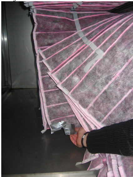
Figur 8.11 Provbit är taget från filtret
