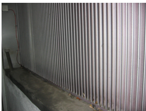
Figur 3.4 Labyrintgaller för att minska fukt till filterna
