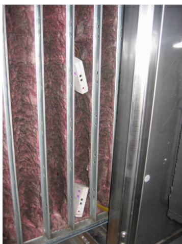
Figur 6.1 Loggrarnas placering i filter. Till höger figur med två filter i objekt 3 med loggrarnas placering.
