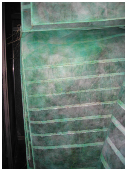
Figur 8.12 Ojämn avskiljningsgrad hos filter
