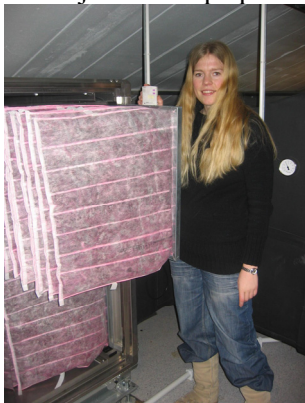
Figur 3.1 Ett påsfilter som fästs med skjutram
