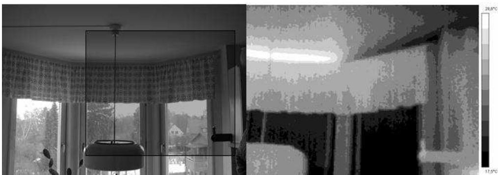
Bild 6: vid punkt 4, tak, kök. Värmeskalan sträcker sig mellan ca 17 - 29 °C.
