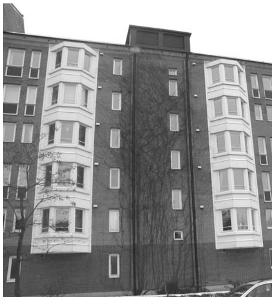
Bild 1: Norrfasad Byggnad A, Kv Bryggeriet
