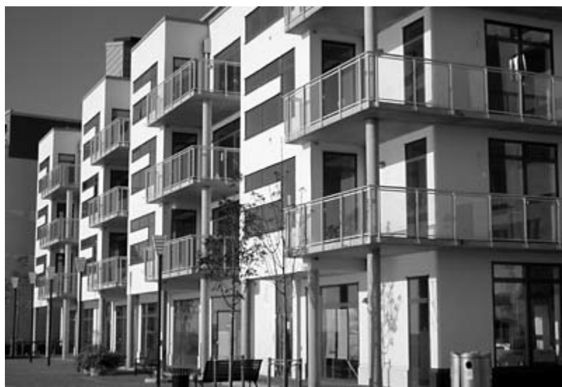
Figur 2.1 Sundshuset sett från sydväst. 2
