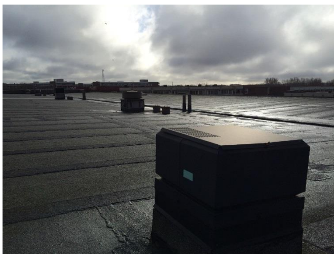
Figur 3.6: Vattensamling på tak (Fotograf: R. Friberg).
