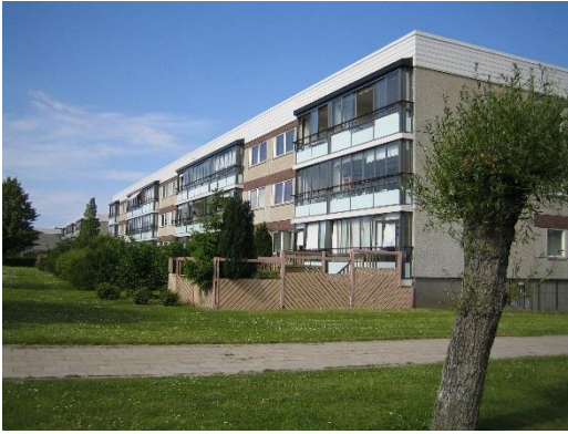
Figur 2.1: Lamellhus i Lindeborg, Malmö [5].
