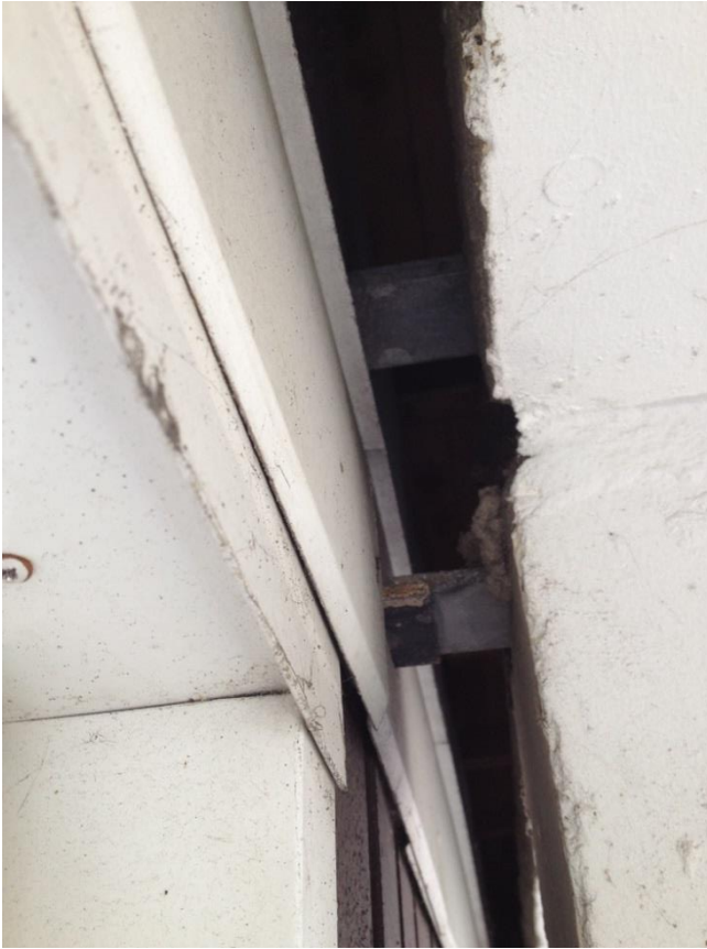
Figur 3.8: Infästning av konsolbalk (Fotograf: V.Karlin).
