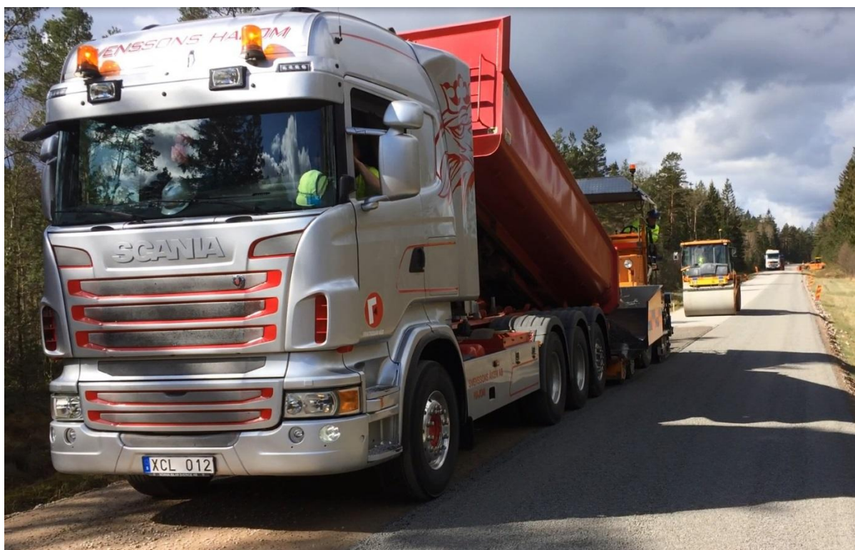
Figur 57: Utläggning av makadam med mekanisk läggare
