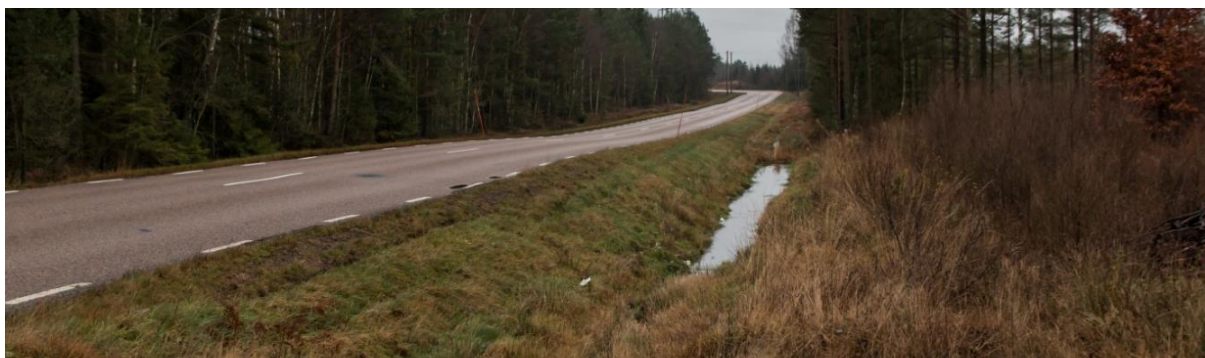
Figur 28: Ojämnheter och vatten i dike
