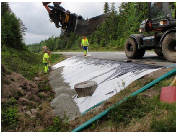
Figur 7: Tätning av innerslänt (Salour & Erlingsson, 2012)
