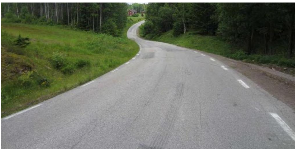
Figur 41: Ett exempel på kulturväg, notera den smala vägbredden och den kuviga linjeföringen (Trafikverket, 2011b)
