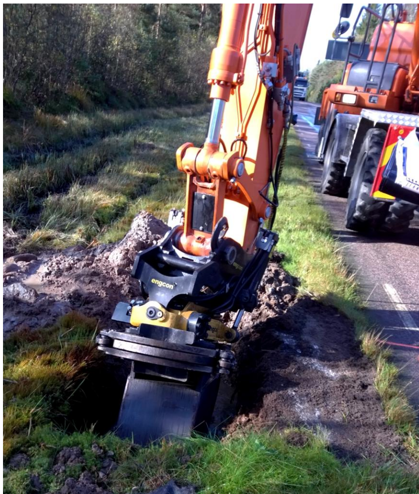
Figur 23: Provgrop i bankslätt med en hjulgrävare
