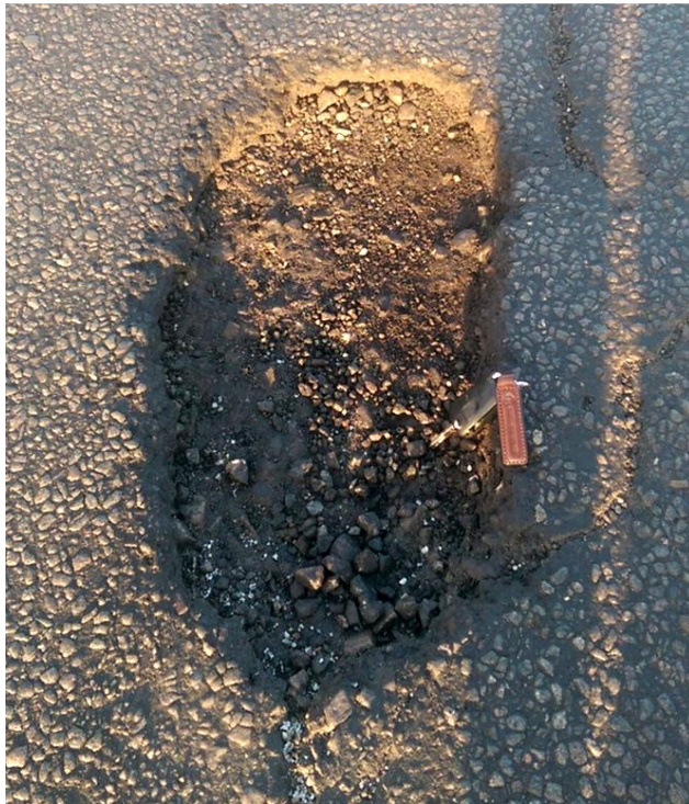
Figur 5: Ett stort slaghål, notera bilnyckeln i bilden
