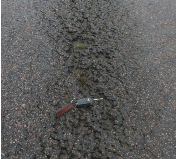
Figur 35: Bristande kantstöd, vilket har lett till att asfalten har spruckit
