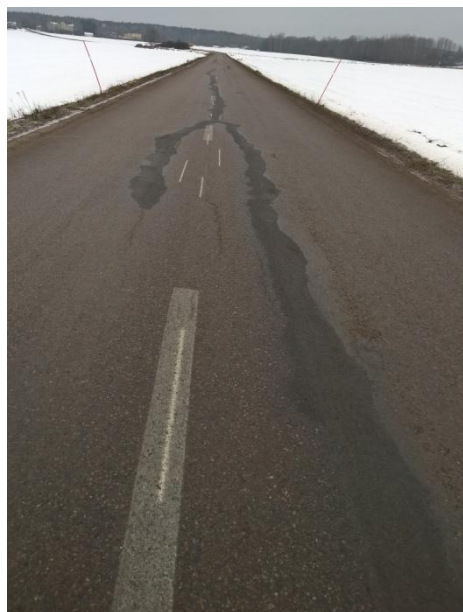
Figur 46: Spricklagning utförd med snabelbil
