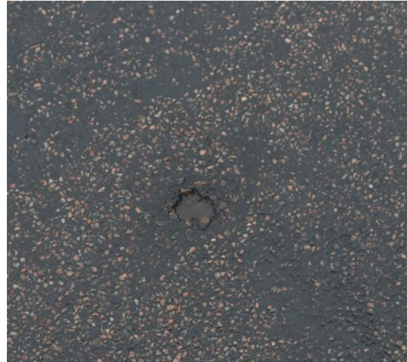
Figur 36: Vatten i ett hål, där stensläpp förekommer
