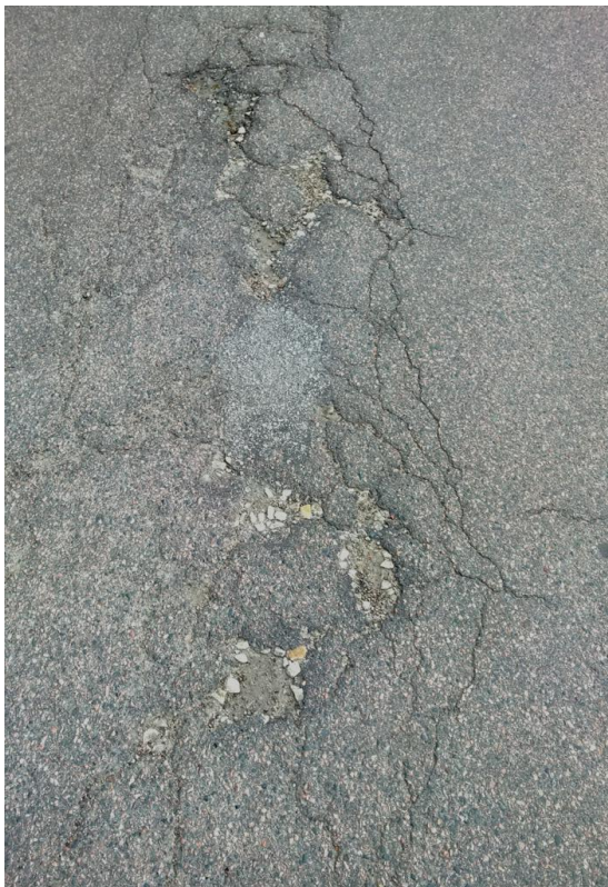
Figur 2: Sprickor och krackeleringar på en bostadsgata, även gamla bristfälliga lagningar visas i bilden
