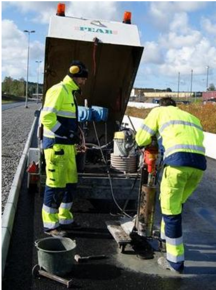
Figur 20: Borrhutrustning på släp (Peab Asfalt, 2015)
