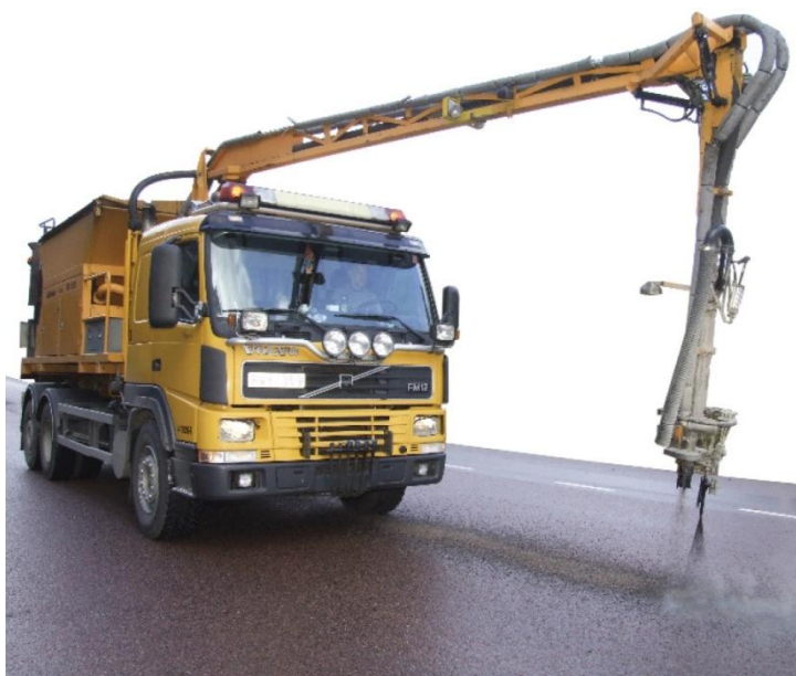
Figur 45: Snabelbil som lagar en spricka (Trafikverket, 2009a)
