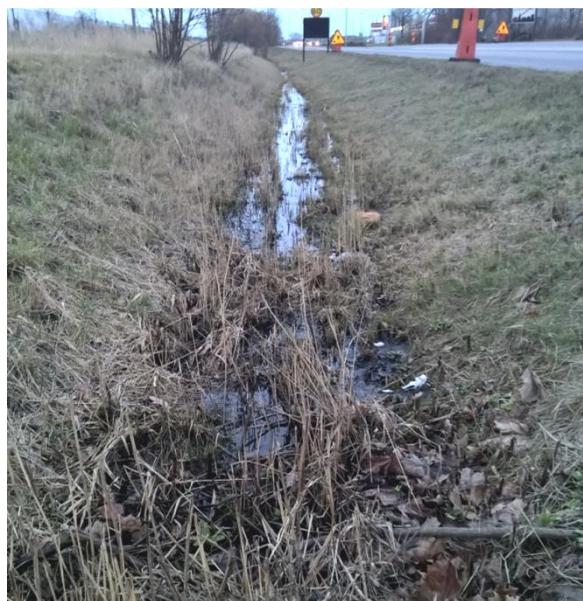
Figur 11: Dike i behov av underhåll
