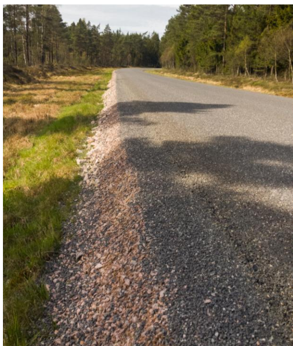
Figur 61: Färdig vägyta efter sopning
