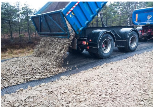
Figur 54: 0-90 mm förstärkningslager spreds på geonät
