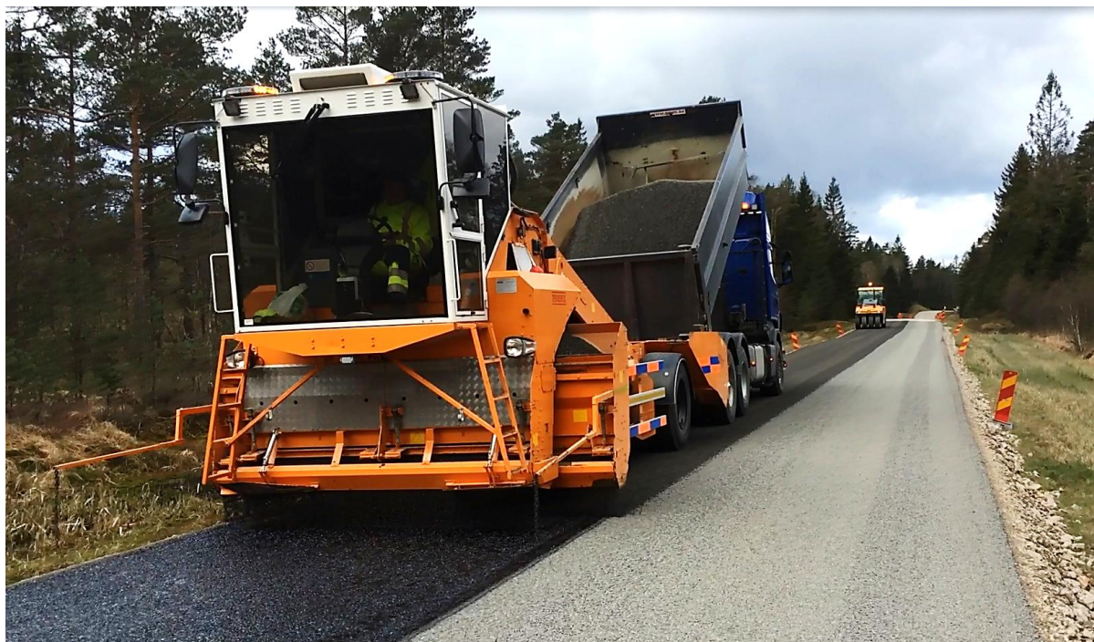
Figur 59: Spridning av kilsten på bindemedlet och makadamen
