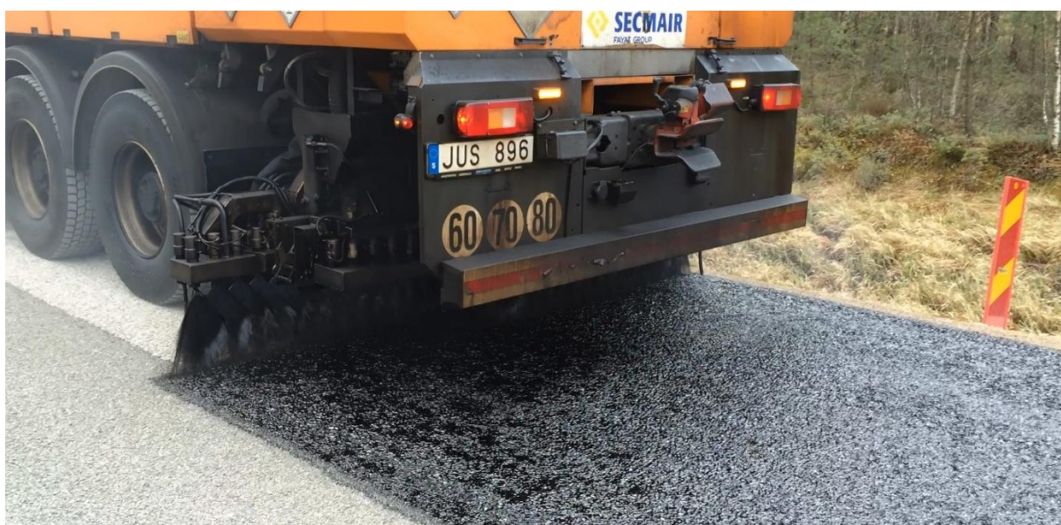
Figur 58: Spridning av bindemedel på makadamen
