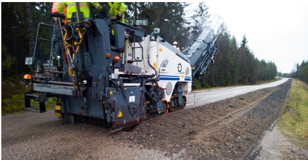
Figur 53: Fräsning av beläggningen på v. 506
