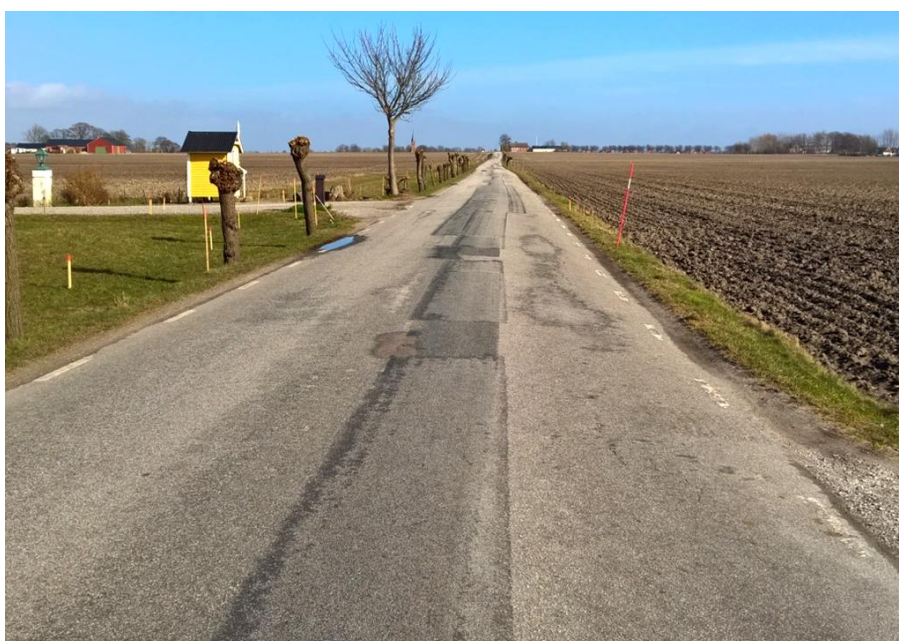
Figur 48: En väg reparerad med HP27, som kännetecknas av de svarta rektanglarna.
