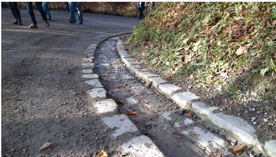
Figur 42: En öppen ränna för ytvattenavledning utanför Zürich i Schweiz
