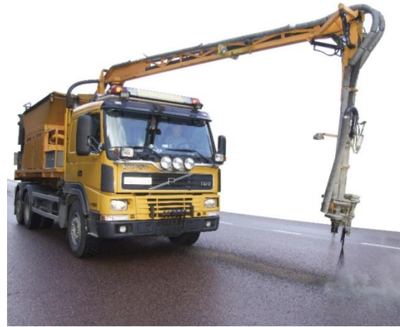
Figur 4: Reparation med snabelbil
