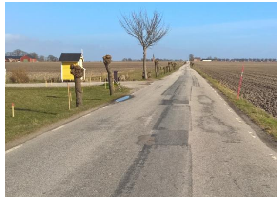
Figur 5: Väg reparerad med HP27.
