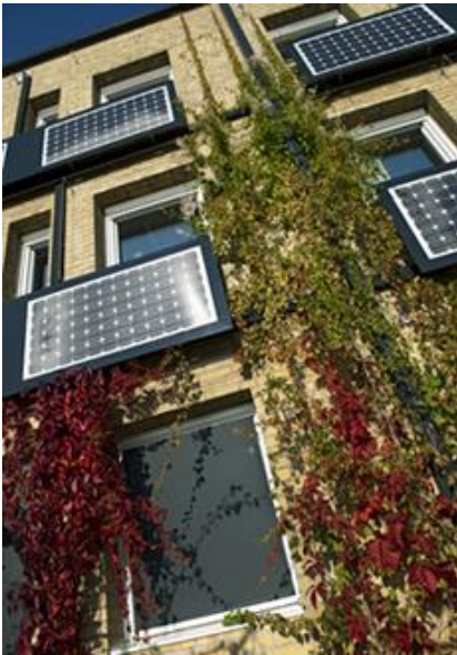
Figur 3.7 Byggnadsapplicerade solceller – fasad (MalmöStad, 2013)
