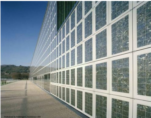
Figur 3.8 Byggnadsintegrerade solceller – fasad (van Noord, 2010)
