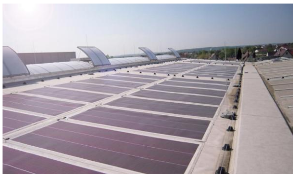
Figur 3.1 Byggnadsintegrerade solceller - platta tak (van Noord, 2010)
