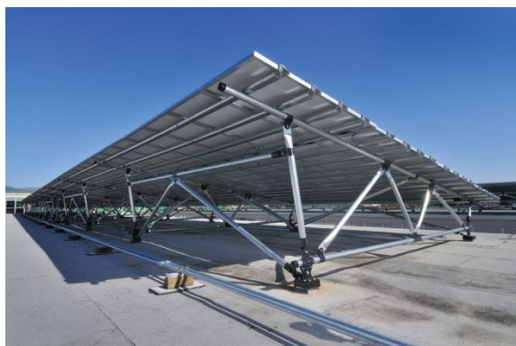
Figur 3.3 Byggnadsapplikerad solcell – platta tak (Solarprofessional, 2013)
