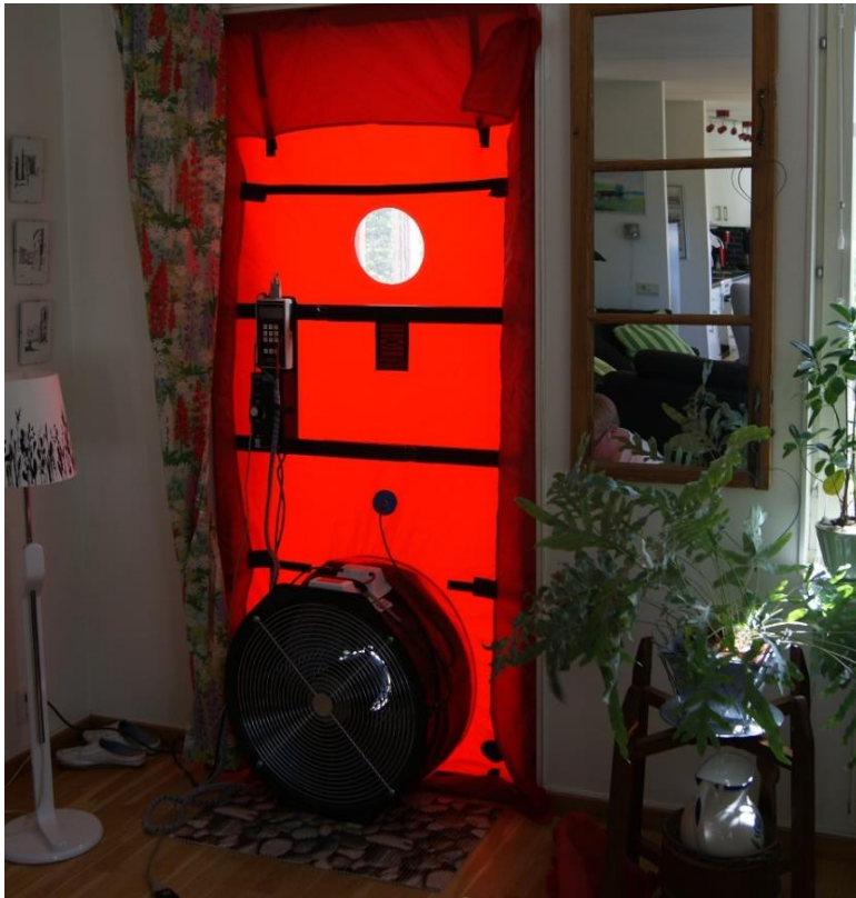
Figur 7. Blower Door monterad i balkongdörr. Foto: J.Guth
