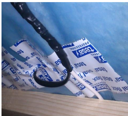
Figur 8. Signaltrådarna lödas ihop och tejpas med eltejp. Genomföringarna genom plastfolien tejpas noggrant.
