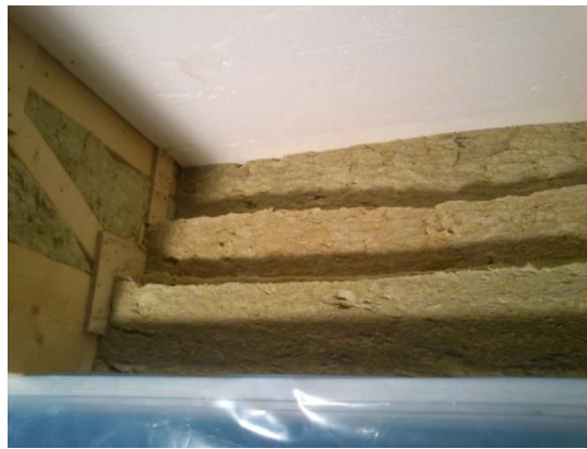
Figur 23. Isolerskivorna närmst takfoten snedskärs för att få en tät anslutning mot den yttre OSB-skivan.
