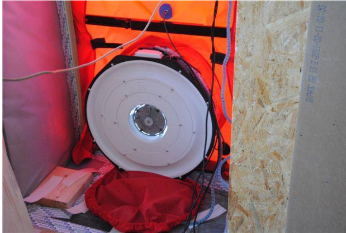
Figur 11. BlowerDoor fläkt vid installation i dörröppning.
