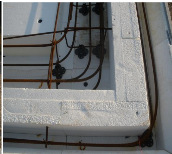
Figur 20. Den inre kantbalken har ett djup på 300 mm, att jämföra med den yttre kantbalkens djup på 200 mm. Klacken skapar djupdifferensen.
