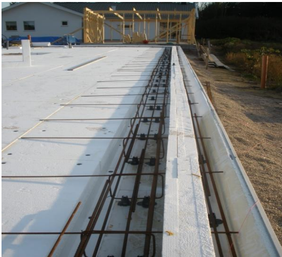
Figur 16. Bygelarmeringen (d=8 mm) skär igenom den inre stående delen av U-et på ett c/c avstånd av 600 mm.
