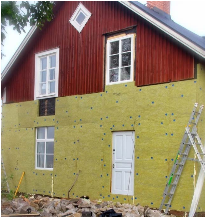
Figur 6. Utvändig tilläggsisolering (Styleroom, 2010).
