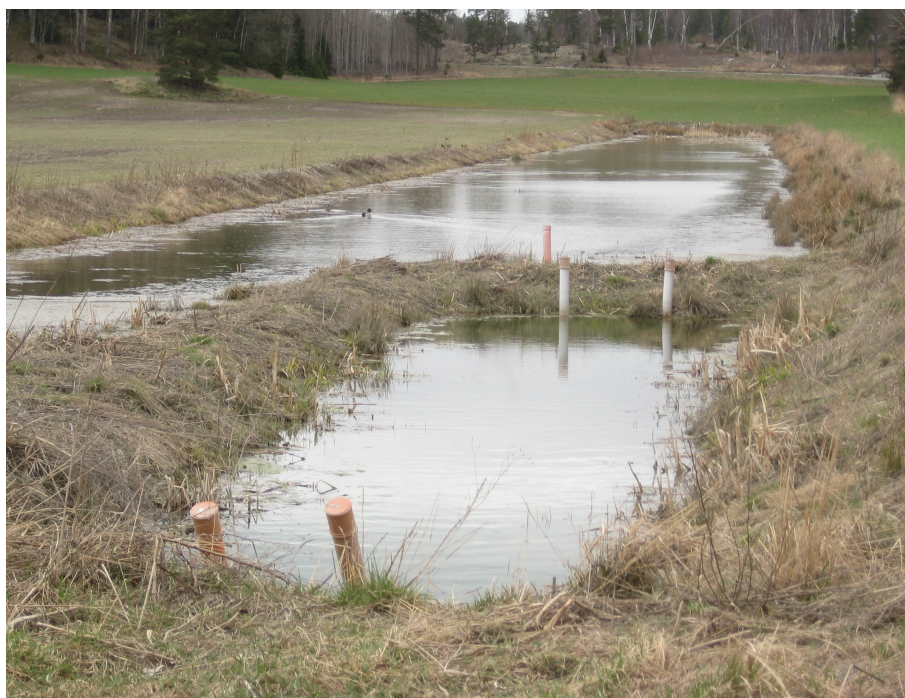
Figur 4.3. Kalkfilterbädd på Ingarö placerad efter en fosfordamm. Vattnet leds in på botten av filtret och rör sig till toppen innan det rinner ut i ett dike. Rören som sticker upp används för att spola systemet (Foto: Therese Hernvall)
