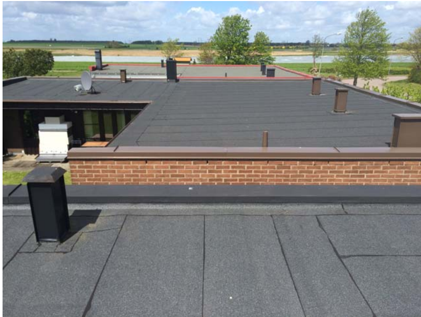
Figur 4.15 Ny takpapp på Holländarehusvägen 5, 3 och 1
