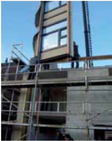
Figur 2.7 Montering av de prefabricerade byggelementen [8].
