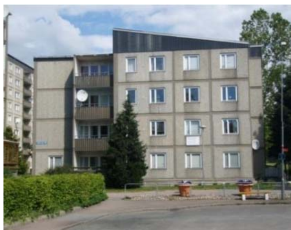
Figur 2.4 Punkthuset på Katjas gata innan renovering [15].
