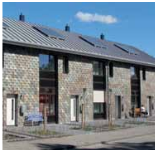
Figur 2.8 Bostadshuset efter renoveringen år 2011 [8].
