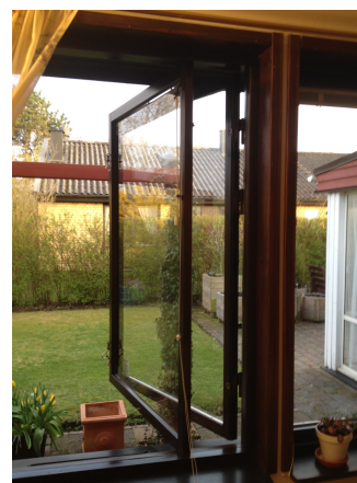
Figur 2.3 Brunlaserat tvåglasfönster med kopplade bågar från ett hus som byggdes 1973.
