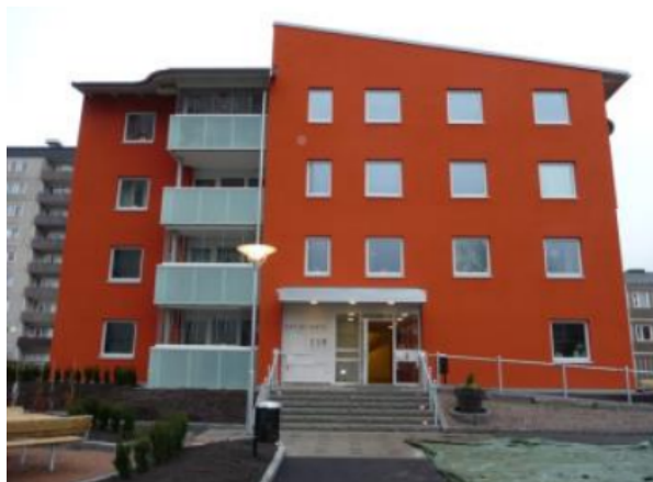
Figur 2.5 Punkthuset på Katjas gata efter renovering [15].
