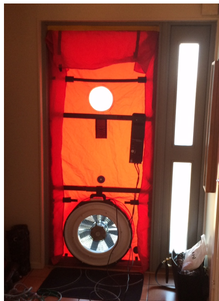
Figur 3.14 En Blowerdoor vid täthetsprovningen på Holländarehusvägen 5, Bjärred.
