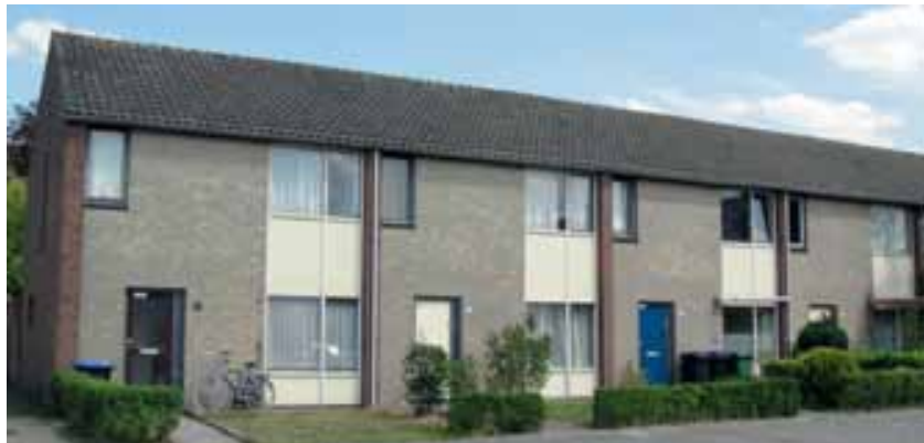
Figur 2.6 Bostadshuset i Roosendaal i Nederländerna innan renovering [8].
