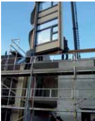
Figur 2.7 Montering av de prefabricerade byggelementen [8].
