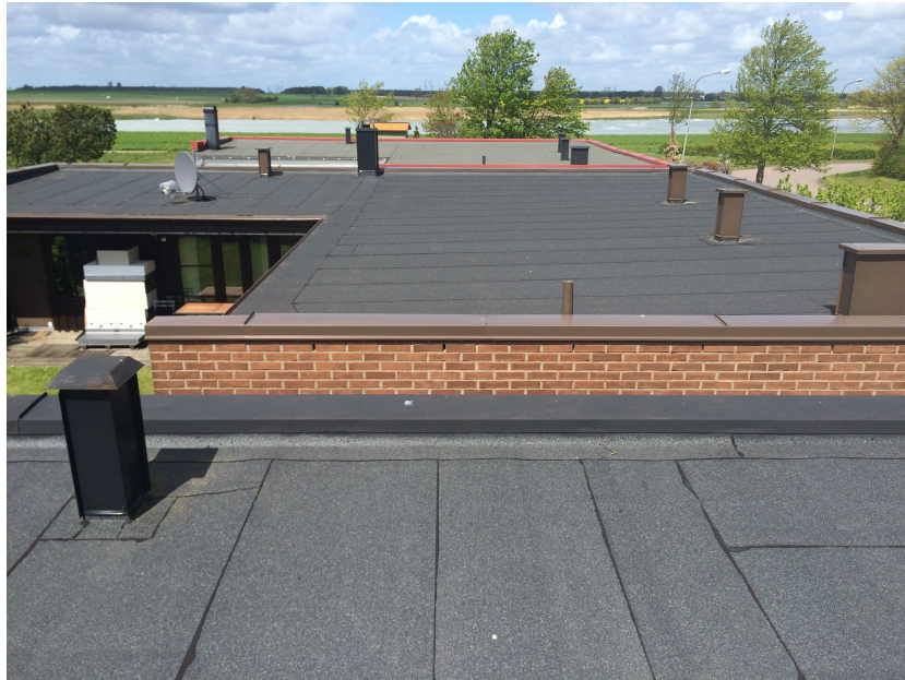
Figur 4.15 Ny takpapp på Holländarehusvägen 5, 3 och 1
