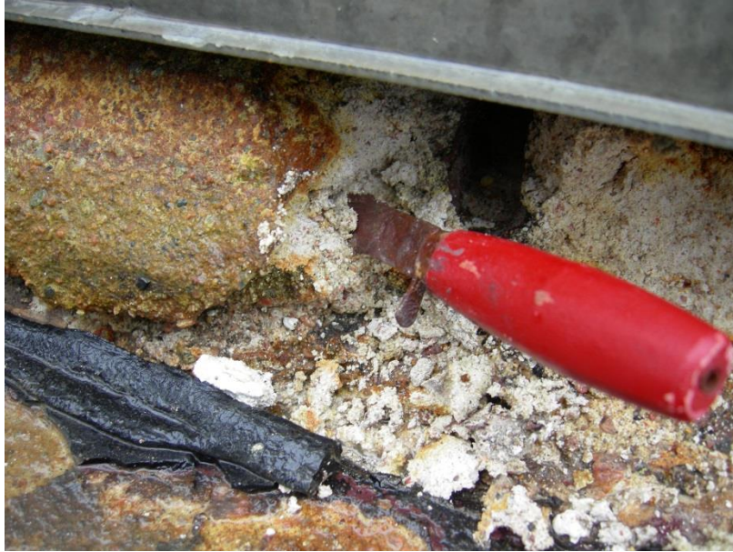
Figur 7 - Betong angripen av svavelsyra (Mårten Janz)
