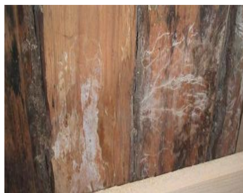
Figur 3.5 Fuktskadat trä, mögel [54].
