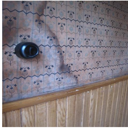
Figur 3.7 Tapet, fuktskadad [57].
