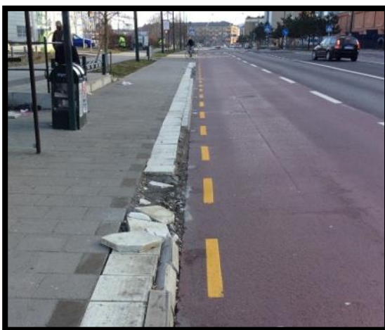
Figur 5.4 Kant- och vegetationsskador från vinterväghållning. Källa: Gatukontoret Malmö stad
