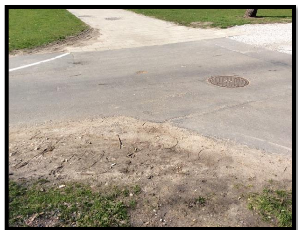
Figur 5.4 Kant- och vegetationsskador från vinterväghållning. Källa: Gatukontoret Malmö stad
