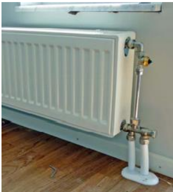
Figur 7.8: Rör genomförning till radiator genom bjälklaget. (byggai.se)
