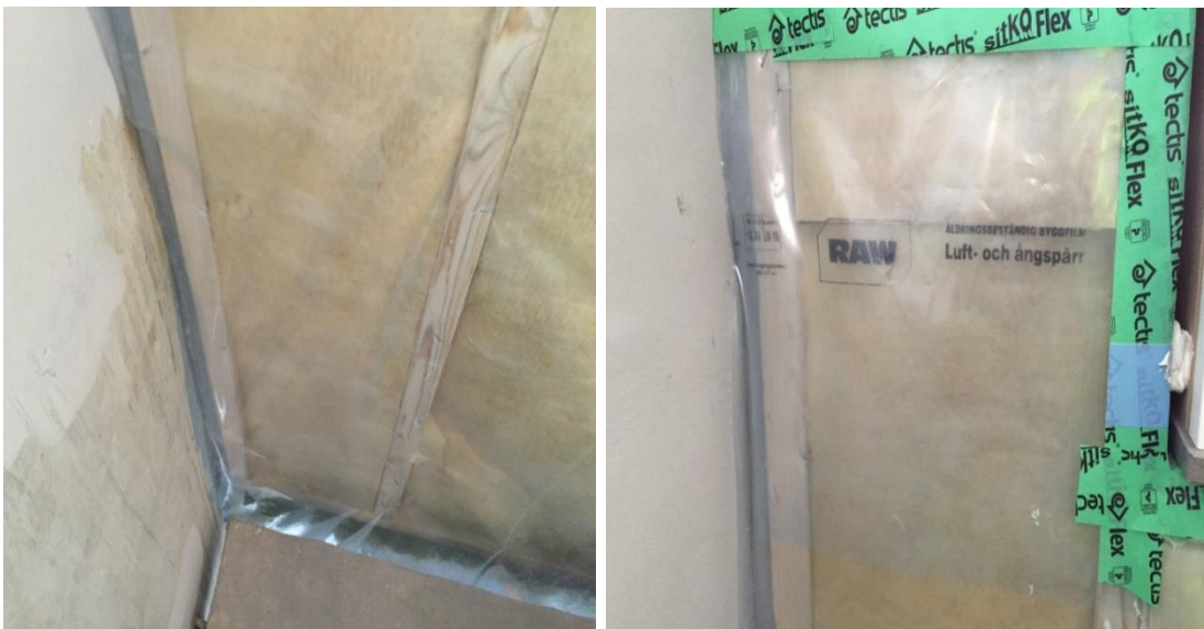
Figur 7.6: Bilderna är tagna på Lunds södra. Här ser man att plasten inte är tät mot mark eller mot bärande betongvägg, luften kommer att ta sig in i byggnaden genom dessa otätheter. Foto: Hanna Stenberg.
