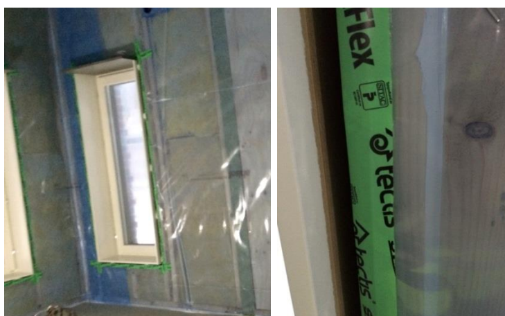
Figur 7.4: Foto på "den nya metoden", tejpning av fönstersmygar. Bilden är tagen på Lunds Södra. Foto: Shanga Namali
