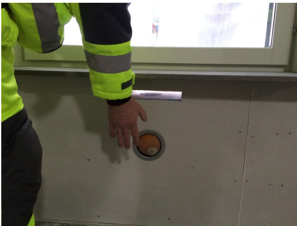
Figur 7.5: Uteluftsventil som har läckage som kan kännas med handen. Bilden är tagen under provtryckningen på Lunds Södra. Foto: Shanga Namali.
