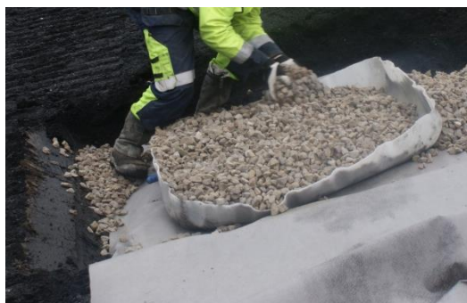
Figur 8 Lysimeter fylls med makadam och täcks sedan med geotextil. Foto: Tove Juhl Andersen
