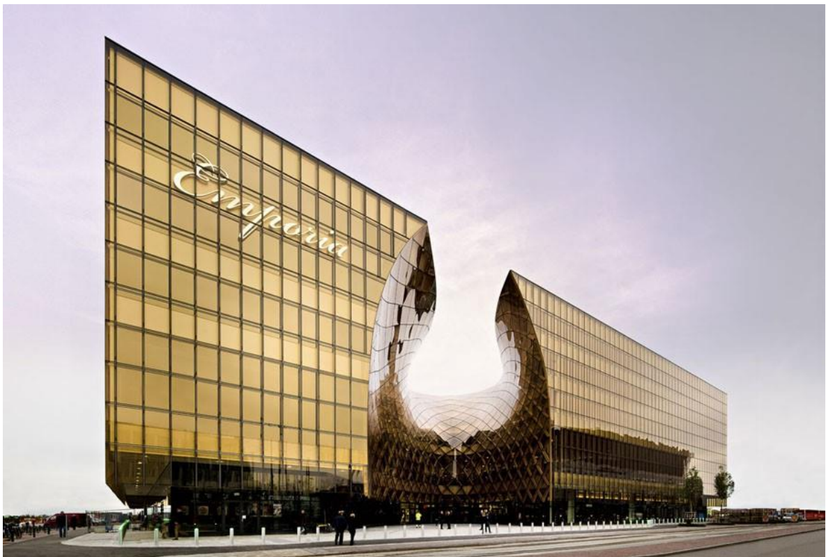
Figur 2.1. Glasfasad på köpcentrat Emporia i Malmö (Söderström, 2012).
