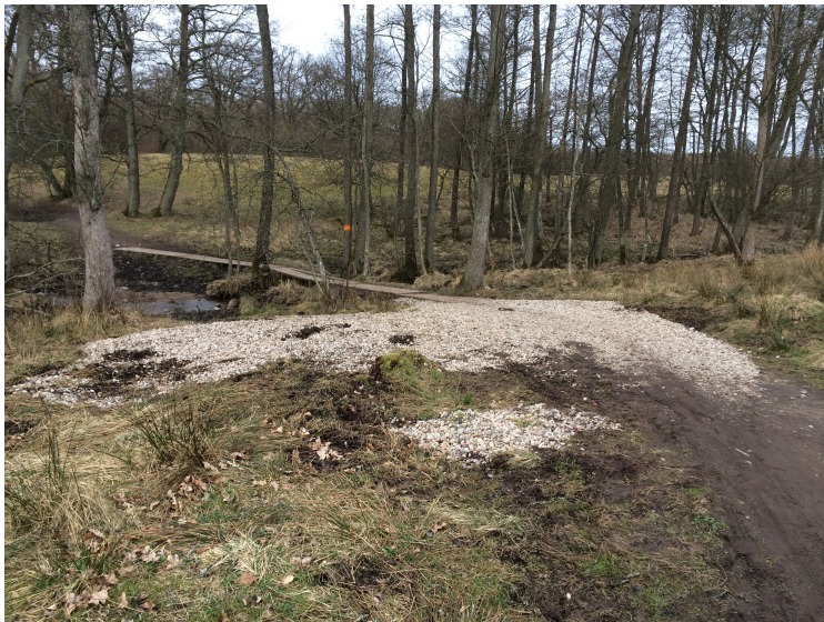
Fig 39. Utlagt sjögrus för att åtgärda ett geggigt parti av stigen genom område 13. 22 mars 2015
