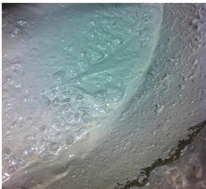
Figur 30. Vattenseparation i kanten av betongmassan.
