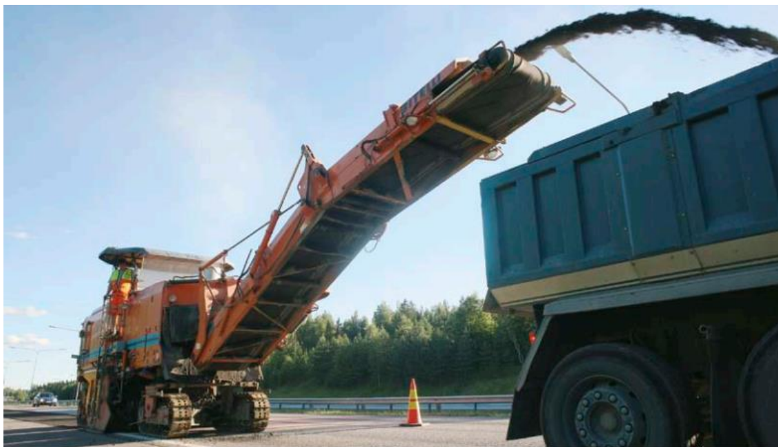
Figur 2.5 – Befintlig beläggning som fräses upp till asfaltgranulat med en fräs (Nordisk Vägforum, NVF, 2012).
