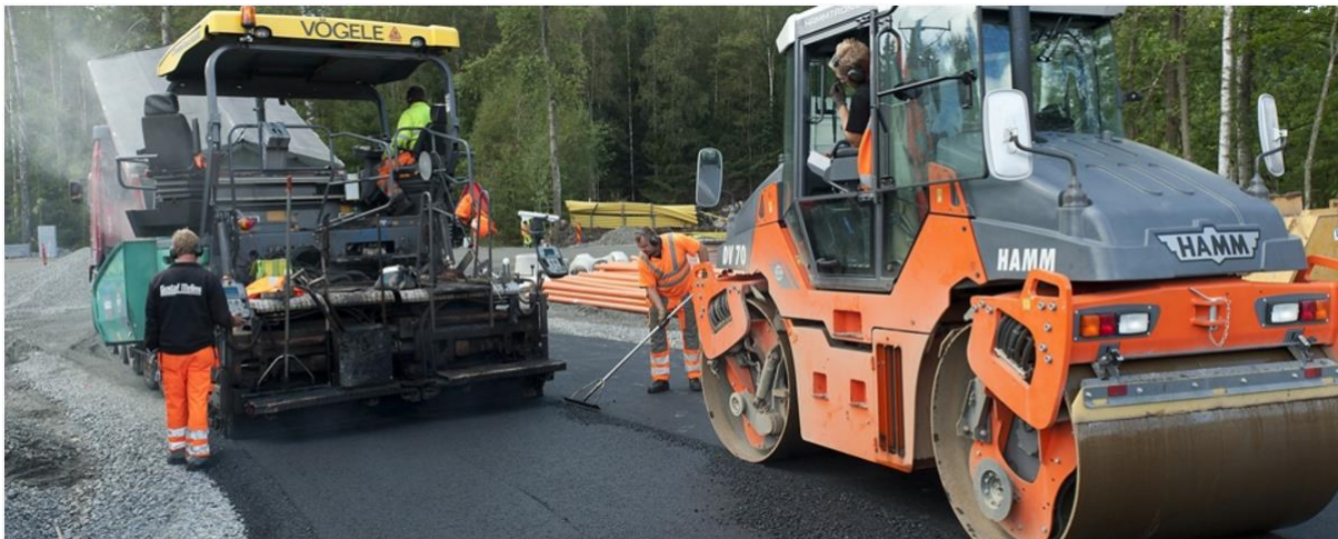
Figur 2.2 – Asfaltläggare t.v. och vält t.h. (Västkustens mark och asfalt AB, 2015).
