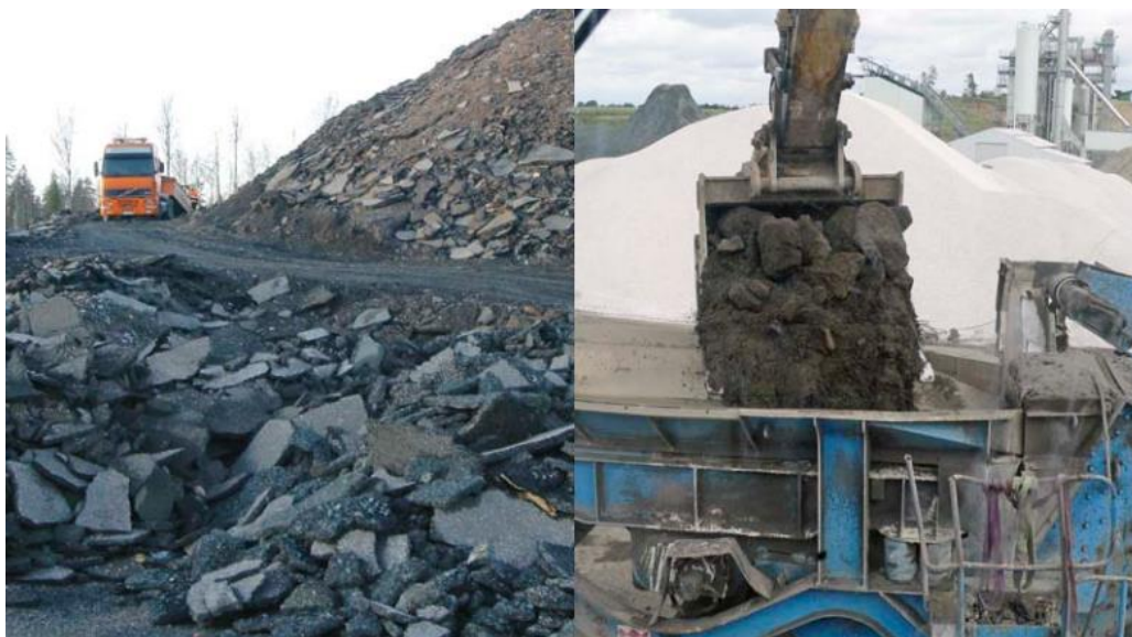
Figur 2.4 – Bild över asfaltsjok och när dessa lastas i en kross (Nordisk Vägforum, NVF, 2012)
