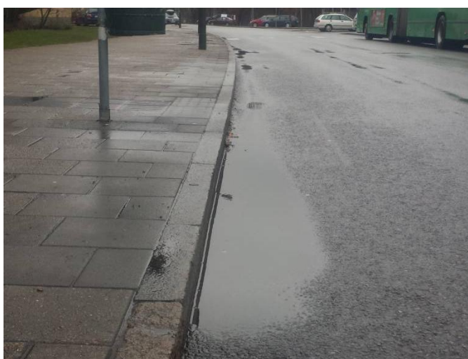
Figur 2.7 Otillräcklig ytvattenavledning på busshållplats Kronetorpsgatan B, Malmö.
