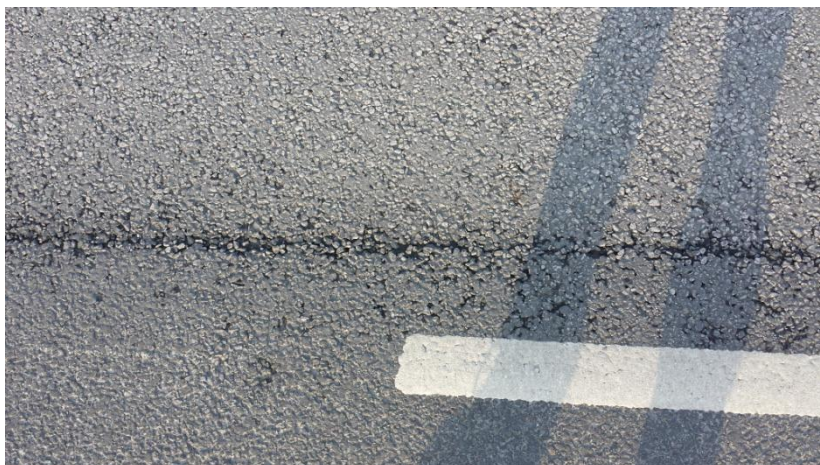
Figur 2.4 Sprickor på hjulspår på busshållplats Professorgatan B, Malmö.
