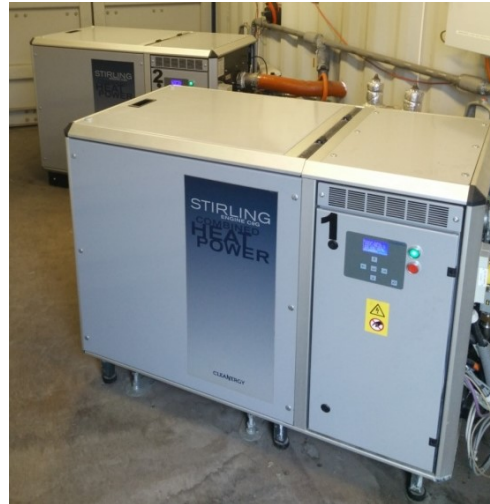
Figur 8: De två stirlingmotorerna på Rönneholmsanläggningen.
