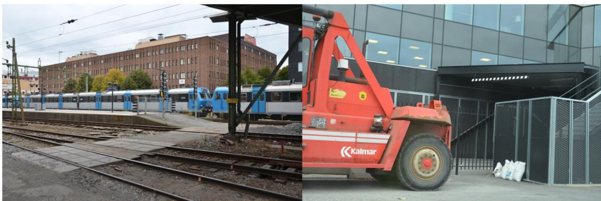
Bild 31 - Till vänster ses serviceväg till plattformen och till höger visa nytt stängsel mot Swedbanks huvudkontor.
