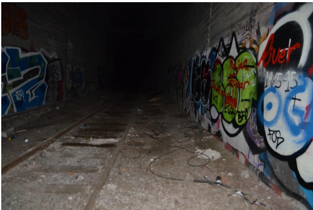
Bild 7 - Tunnel från Stockholms södra till Södersjukhuset där det kan ses spår av att personer har vistats i tunneln.
