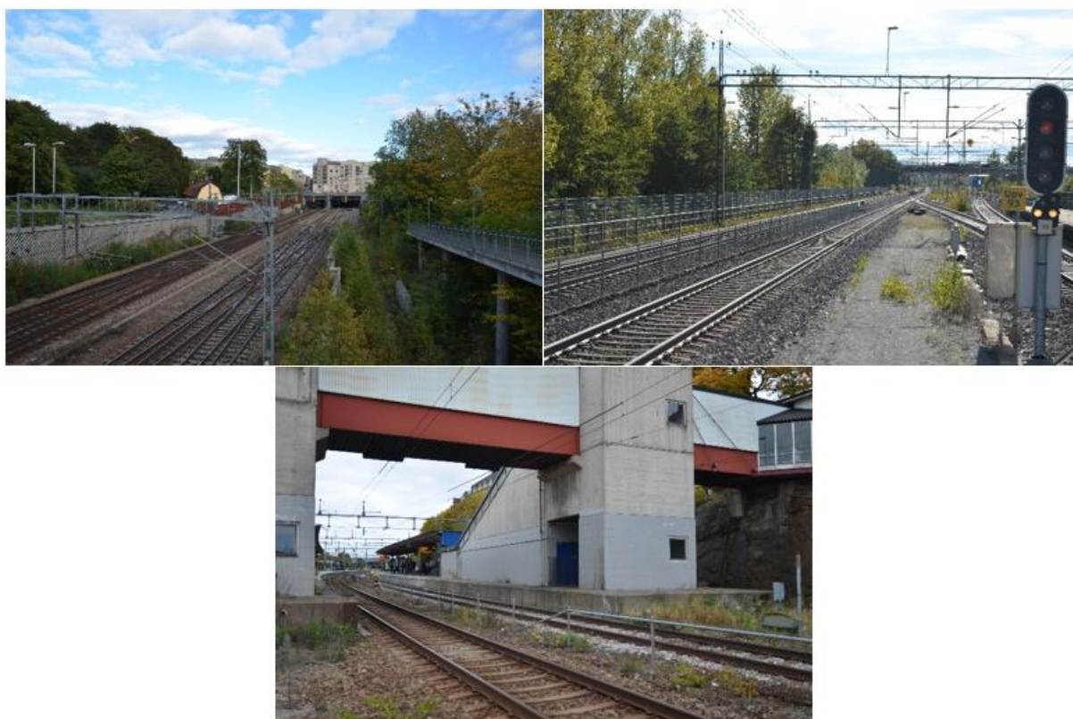
Bild 2 - Bilden till vänster visar spårområdet söder om Stockholms södra, bilden till höger visar spårområdet söder om Upplands Väsby och den nedre bilden visar spårområdet söder om Karlberg där det finns goda möjligheter för suicidala personer att gömma sig.
