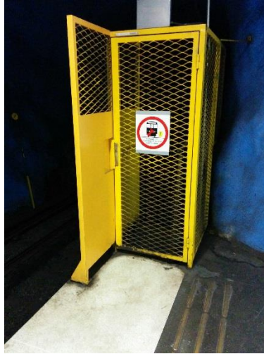
Bild 11 - Visar dörr för servicegång i Stockholms tunnelbanesystem.
