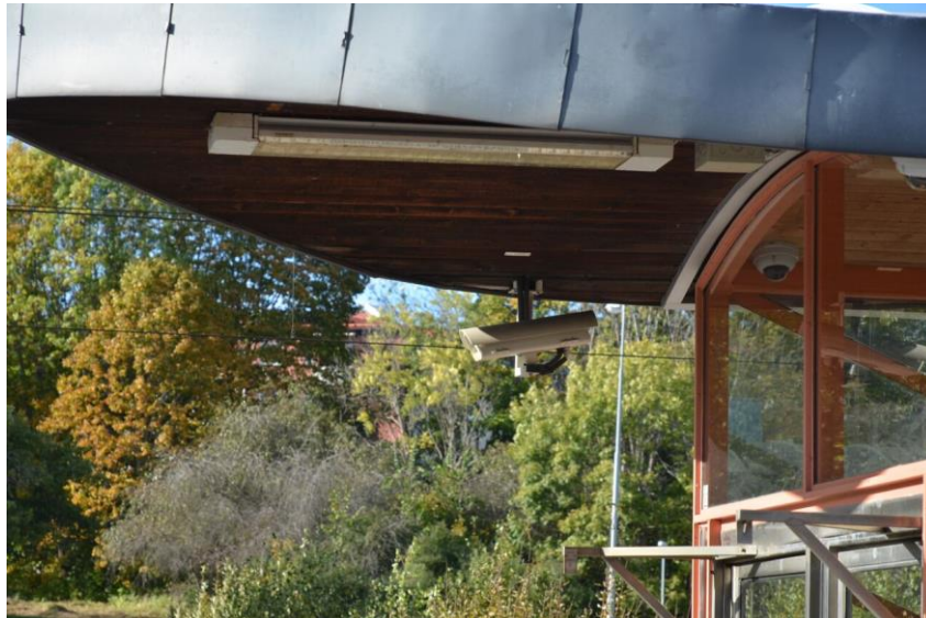
Bild 27 - Visar en av kamerorna som är placerade på stationsområdet.
