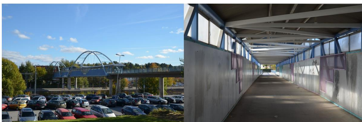
Bild 29 - Visar gångbron över spårområdet.
