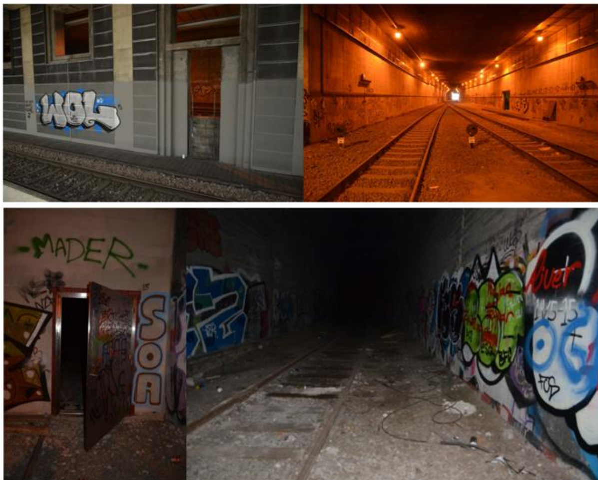
Bild 14 – Övre bilden till vänster visar en av öppningarna i väggen mot servicetunneln, till höger visas servicetunneln i anslutning till öppningen. Den nedre vänstra bilden visar den olåsta dörren till tunneln till Södersjukhuset och till höger kan tunneln som går till Södersjukhuset ses.
