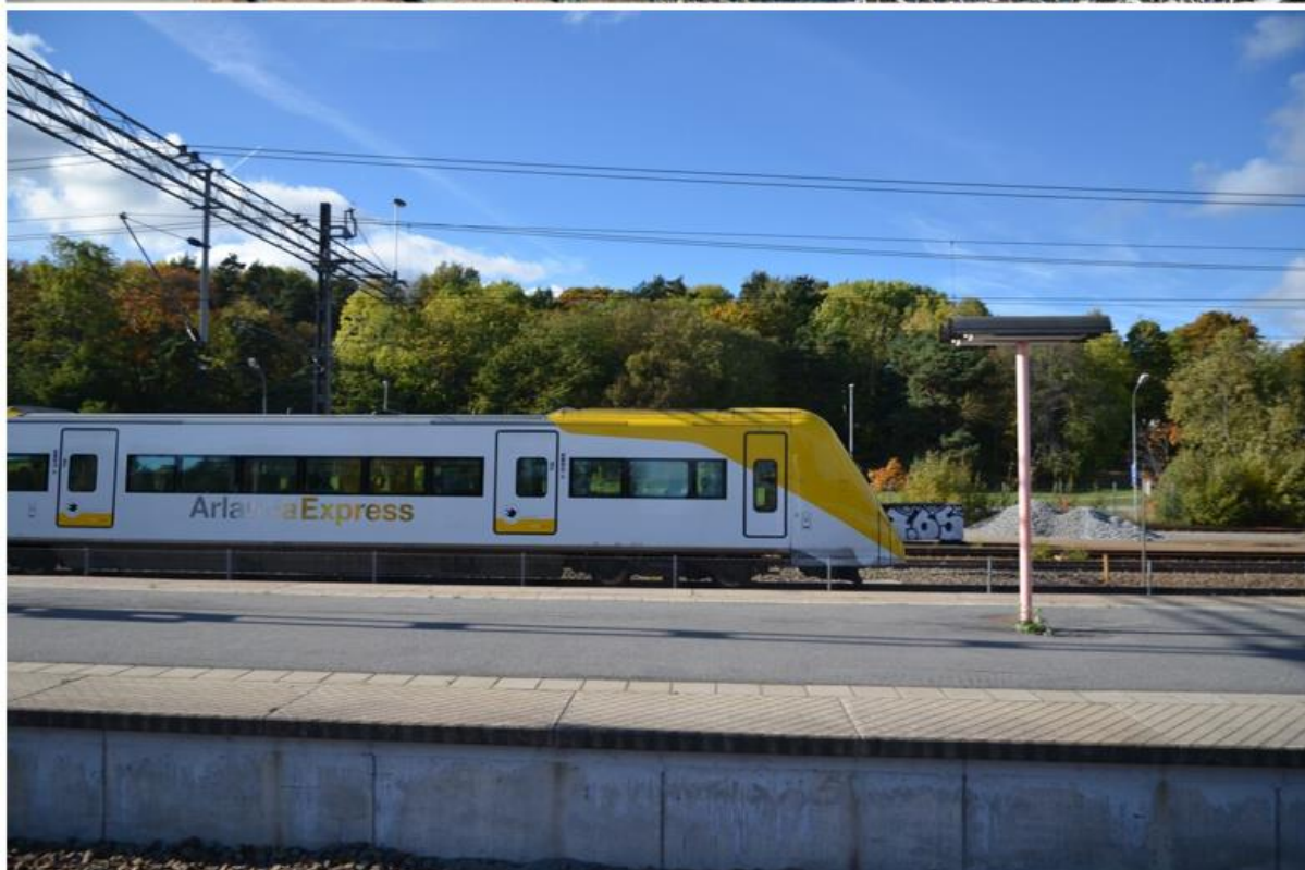
Bild 24 - Visar närheten mellan passerande snabbtåg och perrong, stängsel avsedda att förhindra att personer tar sig ut till spåren samt öppning i stängsel för signalljus.
