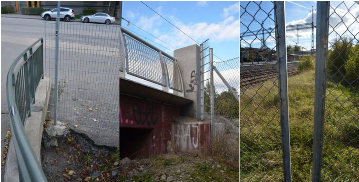
Bild 9 - Visar exempel på undermåligt uppförande av stängsel.
