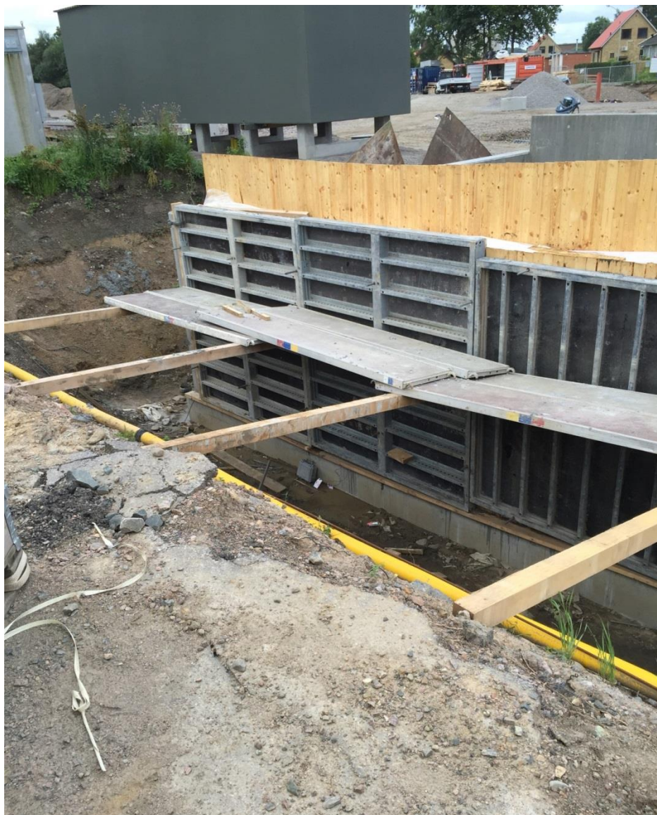
Figur 4. Exempel på hur högt produktionstryck kan få konsekvenser på arbetsplatsen. I det här fallet har moment med att bygga en säker byggställning hoppats över. Källa: Egen Bild 2015.
