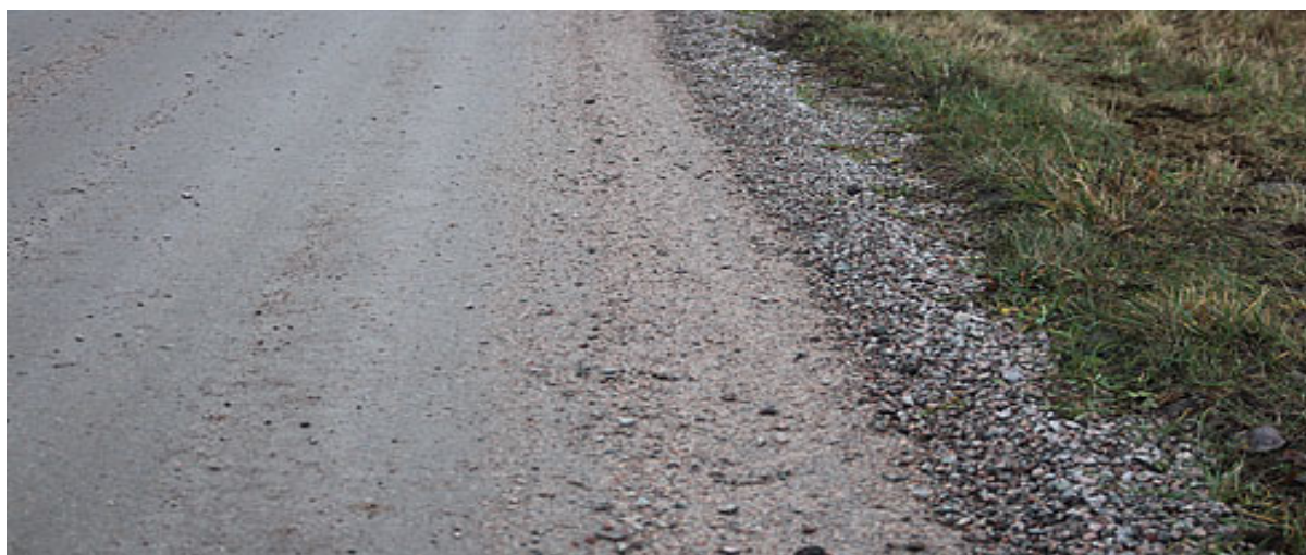
Figur 4: Löst grus som har samlats i väggkant (Kunskap Direkt, 2015a).
