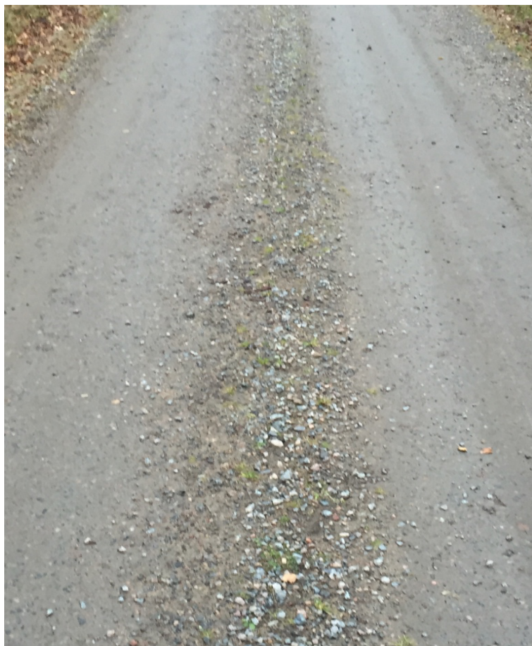
Figur 28: Tydlig spårbildning vilket gjort att gräs börjat växa i vägmitt. Foto: Författaren.
