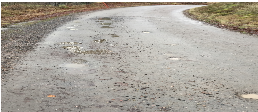
Figur 24: Slaghål har bildats på flera ställen på vägen. Foto: Författaren.
