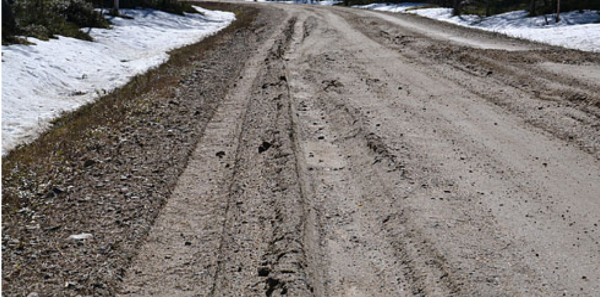
Figur 5: Ytuppmjukning på grusväg med efterföljande spårbildning (Kunskap Direkt, 2015b).
