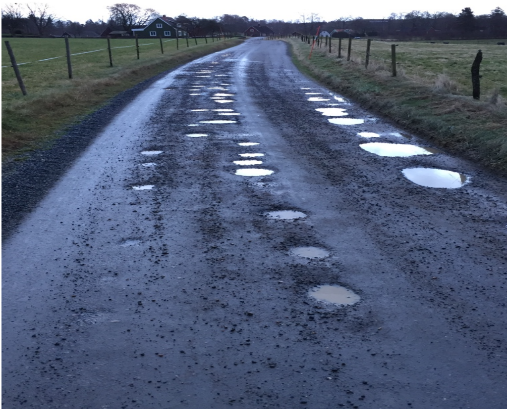
Figur 27: Sammanhängande slaghål. Foto: Författaren.
