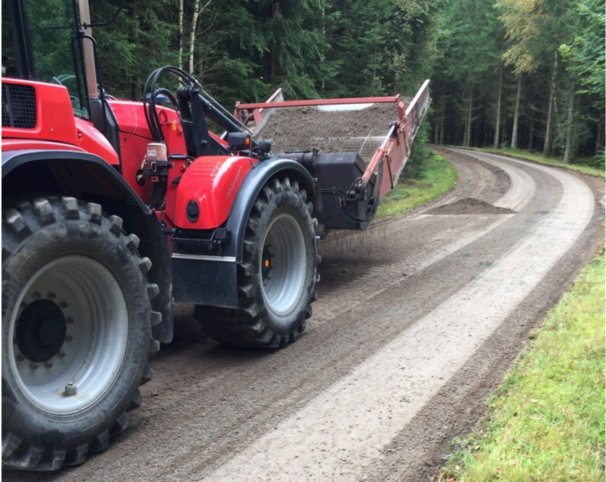
Figur 50: Grusåtervinning med traktorgrävare utrustad med galler-vibratorskopa. Foto: Författaren.
