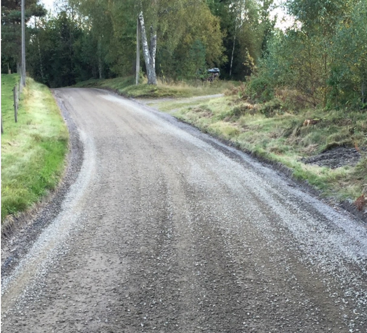
Figur 52: v.1890 efter utförd kantskärning och grusåtervinning. Foto: Författaren.
