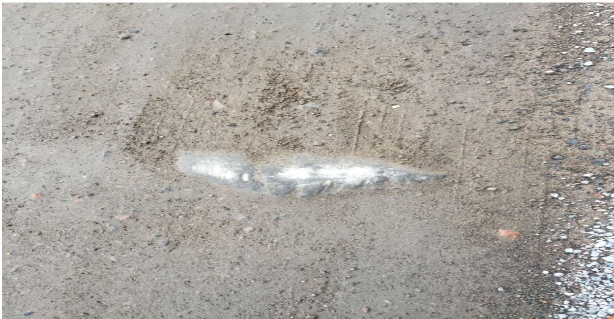
Figur 25: Uppträngd sten i vägytan. Foto: Författaren.
