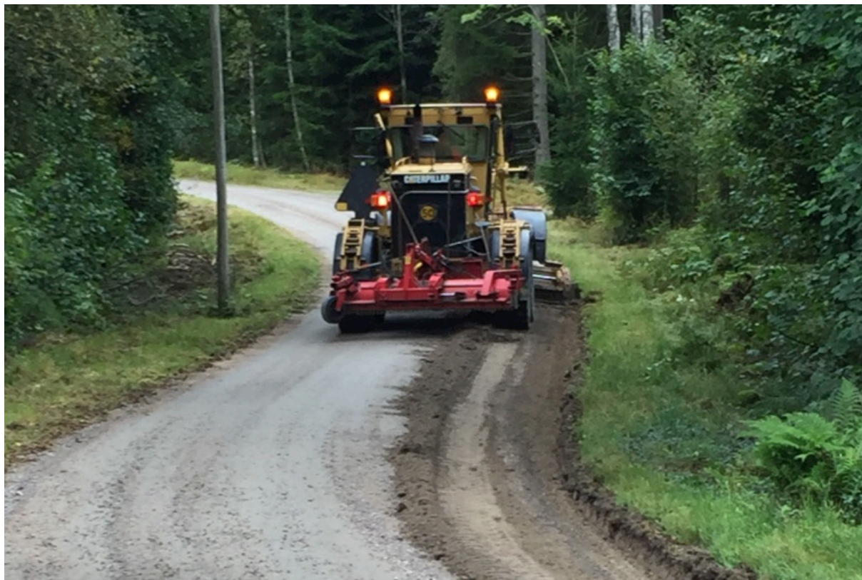
Figur 48: Kantskärning med väghyvel. Foto: Författaren.
