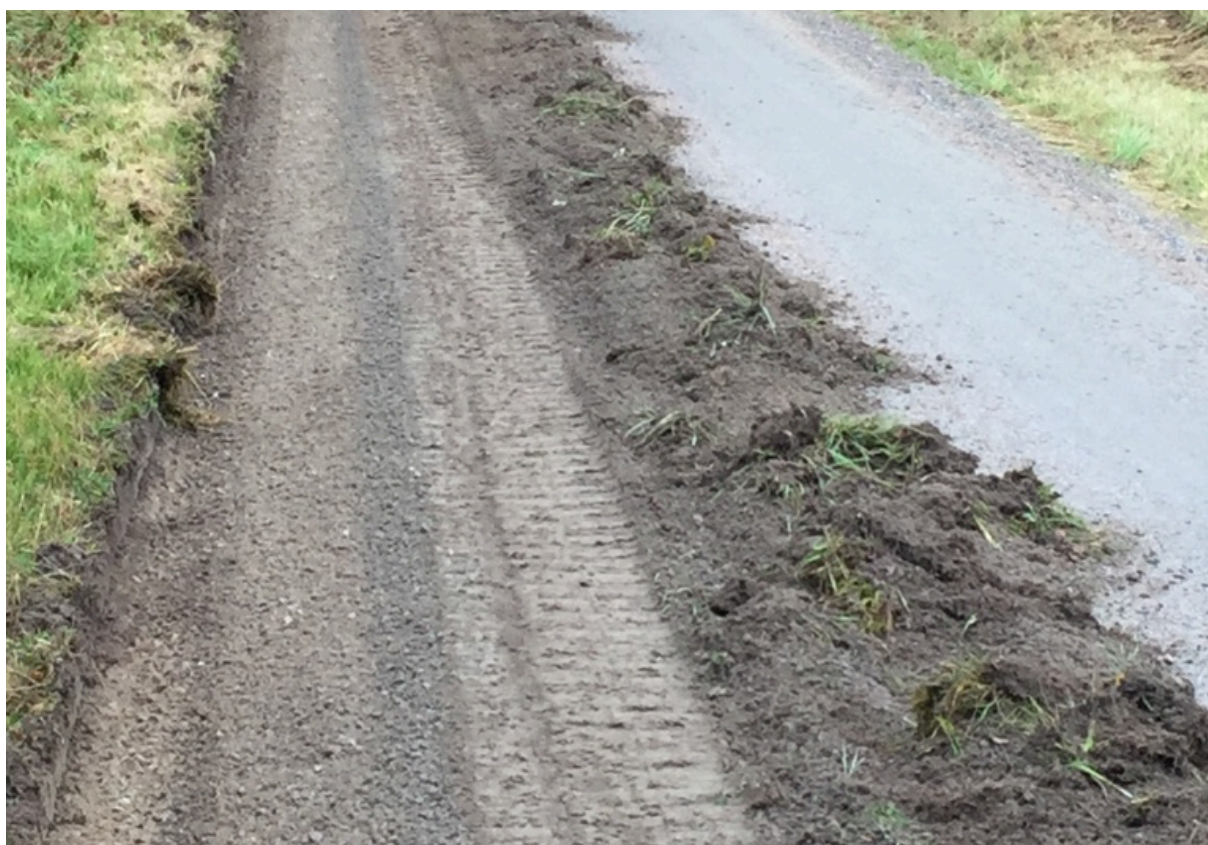
Figur 49: Material som dragits in i samband med kantskärning. Foto: Författaren.
