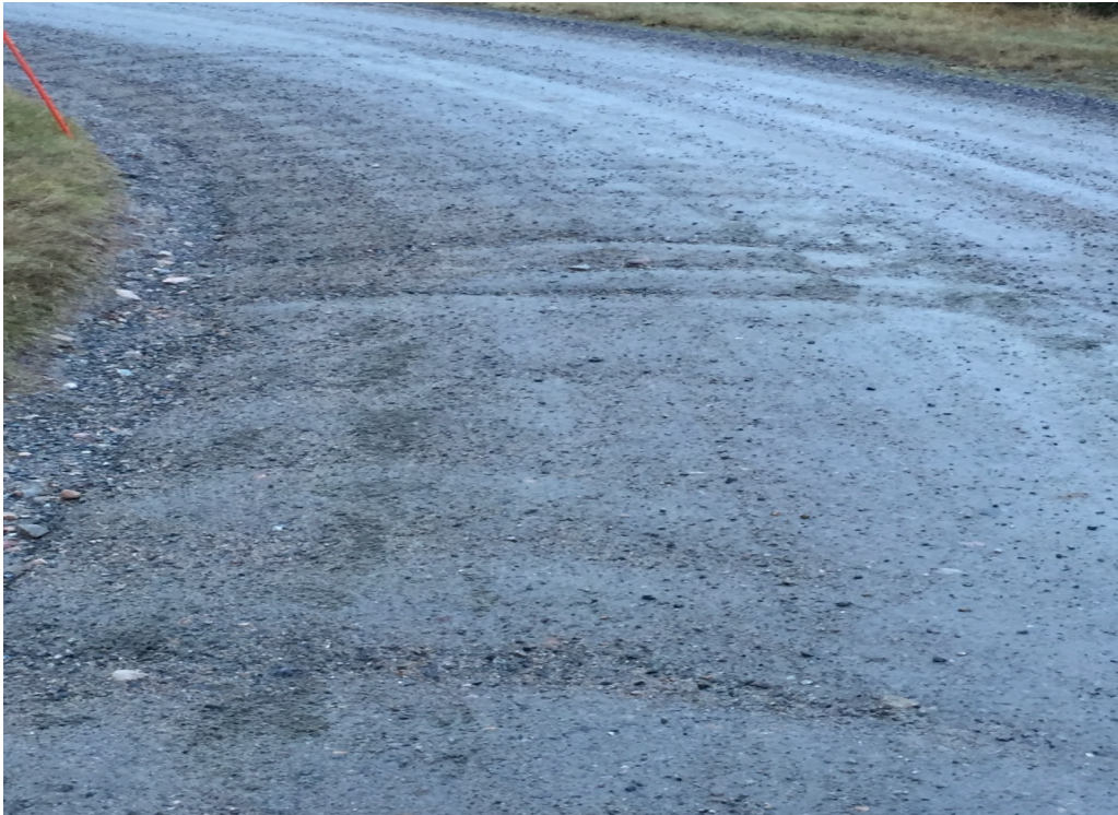
Figur 26: Tvättbräda som har bildats i backe. Foto: Författaren.
