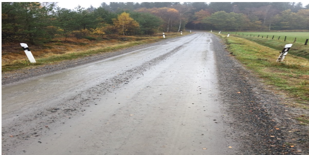
Figur 39: Låg bärförmåga, men inga ytliga skador. Foto: Författaren.
