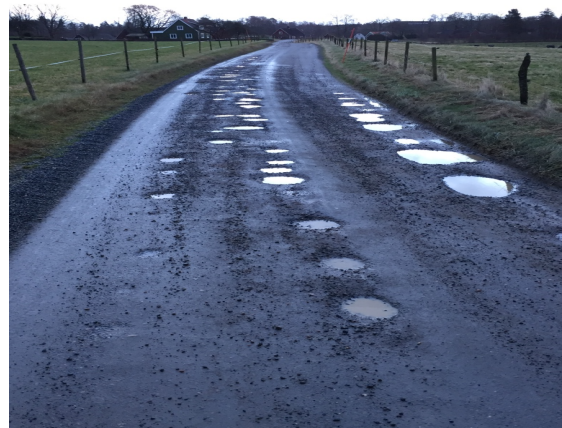
Figur 1: Ojämnheter som uppstått på vägen till följd av att vatten inte kunnat rinna av och därmed blivit kvar på vägen. Foto: Författaren.
