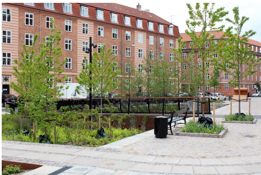
Figur 3.19 – De lägst belägna delarna av Tåsinge plads som fungerar som fördröjningsmagasin (Foto: Klimakvarter Østerbro. Klimakvarter, 2015).
