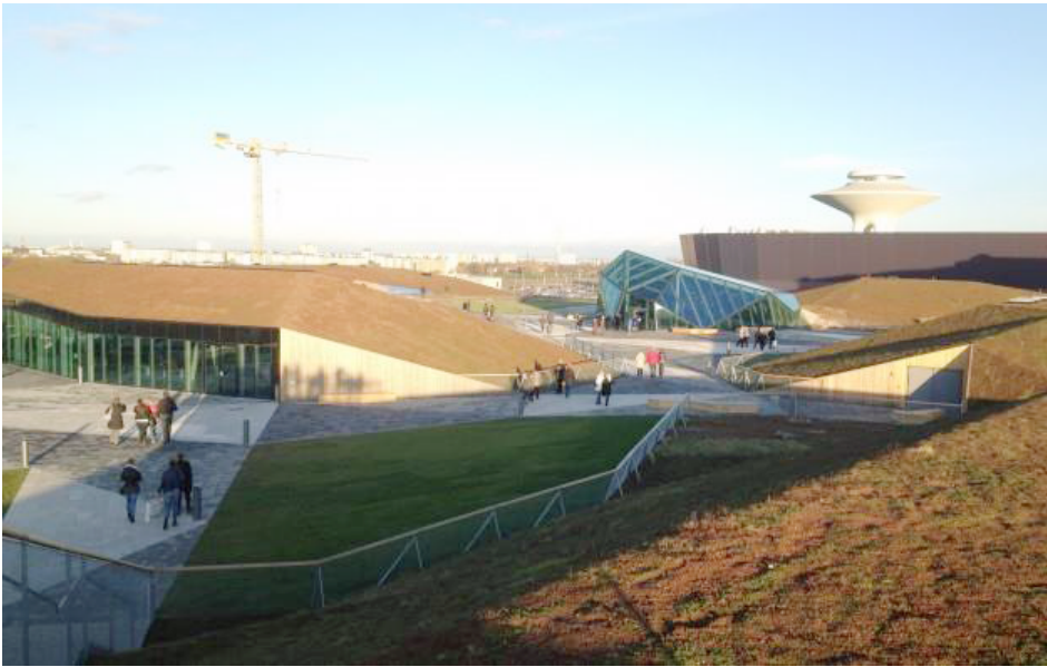
Figur 3.15 – Grönt sedumtak på Emporia köpcenter, Malmö (Foto: Larsson, 2012).
