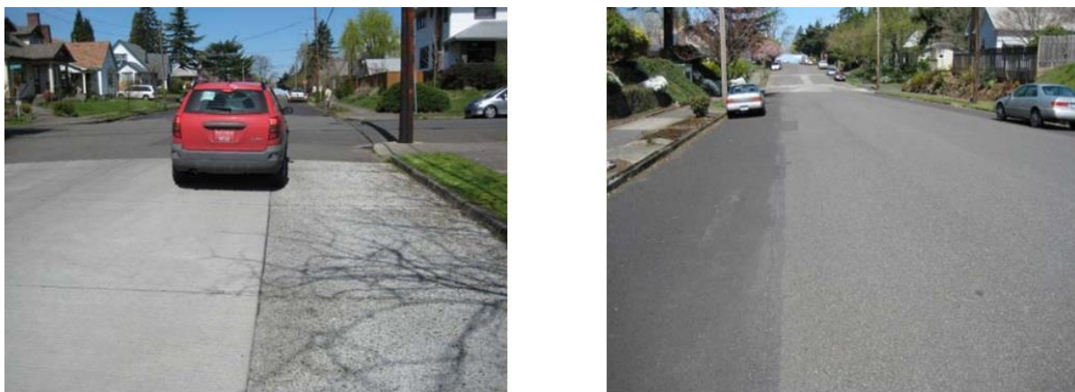
Figur 3.6 – väg av betong med parkeringsyta av permeabel betong (t.v.) och asfaltväg med parkeringsyta av permeabel asfalt (t.h.). (Foto: City of Portland, 2005a).
