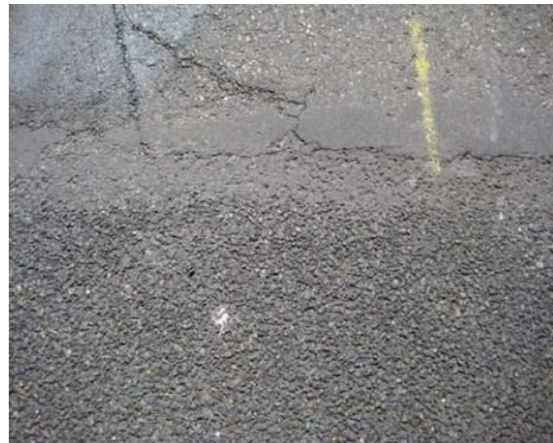
Figur 3.8 – Närbild på permeabel asfalt (t.v.) och permeabel asfalt intill vanlig asfalt (t.h.) (Foto: City of Portland, 2005a).
