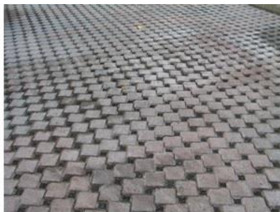
Figur 3.9 – Installation av betongbeläggning över infiltrationsmagasin (t.v.) och det färdiga resultatet (t.h.) (Foto: City of Portland, 2005b).
