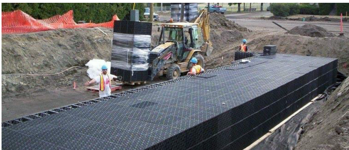
Figur 3.4 – Anläggning av ett kassettmagasin (Foto: Wiktorp Konsult & Trading AB, 2015).
