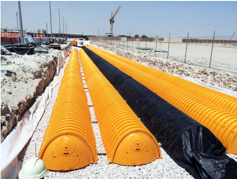
Figur 3.5 – Anläggning av dagvattenkammare i Mellanöstern (Foto: Poltronieri, n.d).
