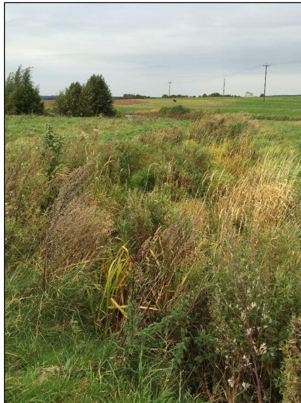
Figur 17: Igenvuxen inloppsränna, Eslöv 46
