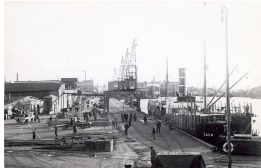
Södra hamnen under 1920- eller 30-talet. (Planbeskrivning, Oceanhamnen. 2014-08-26 Helsingborg stad.)
