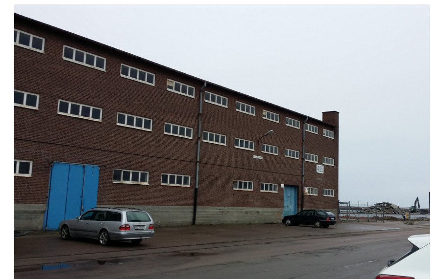
Östra fasaden med repetition av långsmala fönster.
