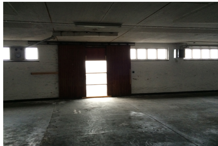
Plan 1, små fönster och tidigare inlastningsport med ny dörr.
