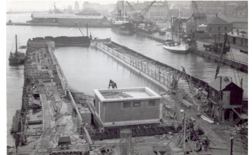
Nuvarande torrdocka under uppbyggnad. (Planbeskrivning, Oceanhamnen. 2014-08-26. Helsingborg stad.)
