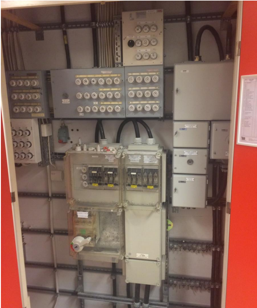
Figur 19. Bild på elnischen från platsbesöket.
